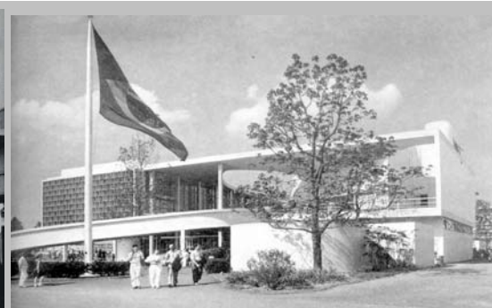
Figura 4 – Fachada Principal Pavilhão Brasileiro.
