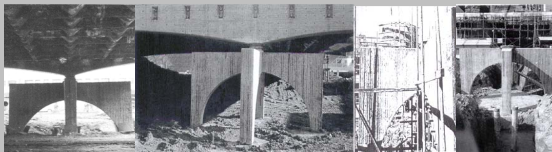
Figura 80 – Detalhe do apoio transformado em quatro pontos, originado pelo encontro de dois arcos.
