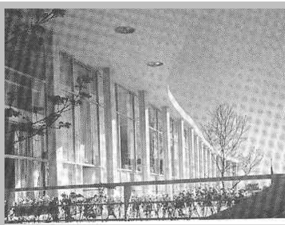
Figura 16 – Fachada interna, posição leste. Fonte: DECKKER, 2002, p. 62.
