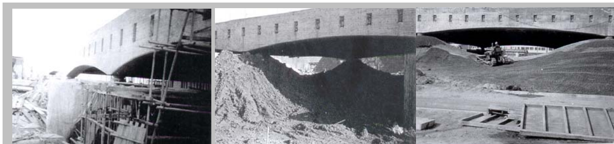
Figura 72 – Cobertura em concreto aparente- arcadas estruturais, pilares 3 e 4. Fonte: Diário executivo de obras, etapa construção 23 nov. 1969. Fotos fornecidas pelo arquiteto, em entrevista.
