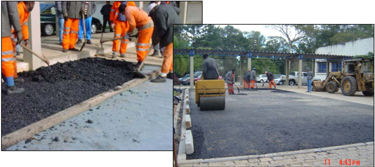
Figura 3.34. Assentamento do revestimento asfáltico.
