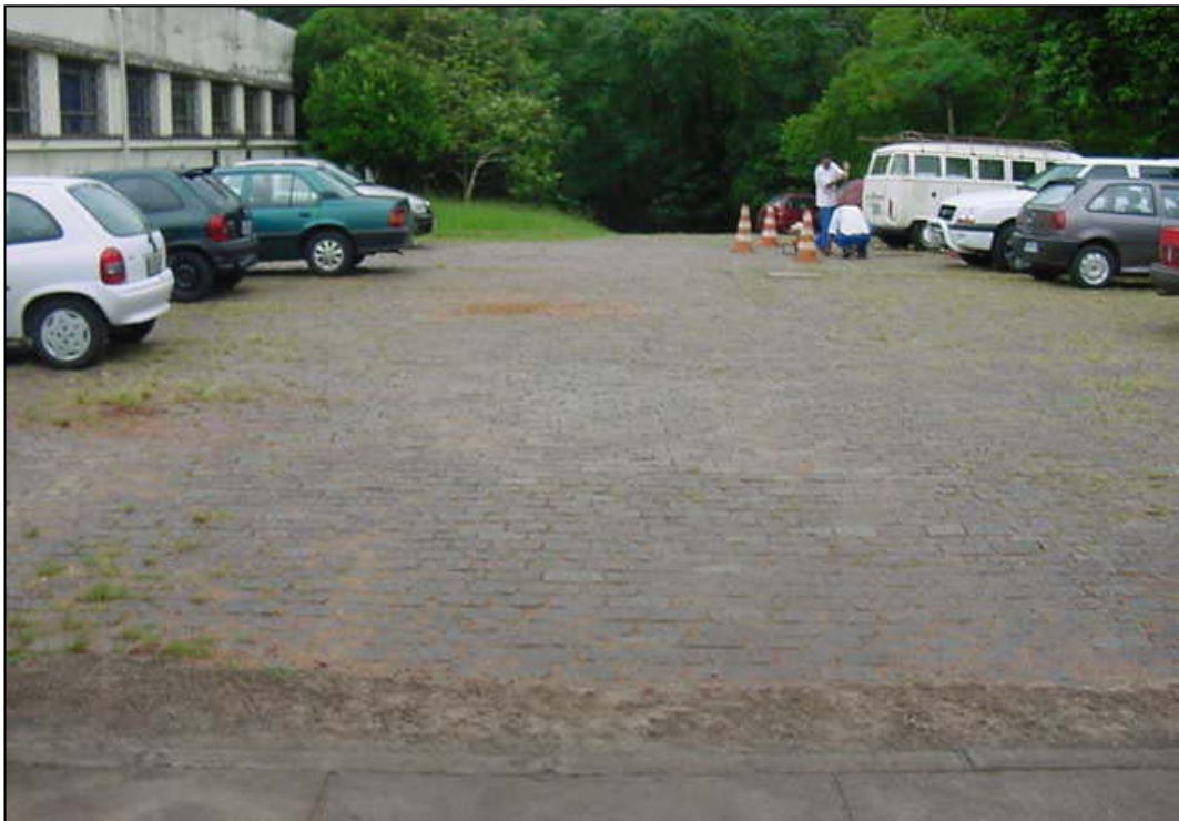
Figura 3.28. Revestimento anterior do pavimento com blocos de granito.
