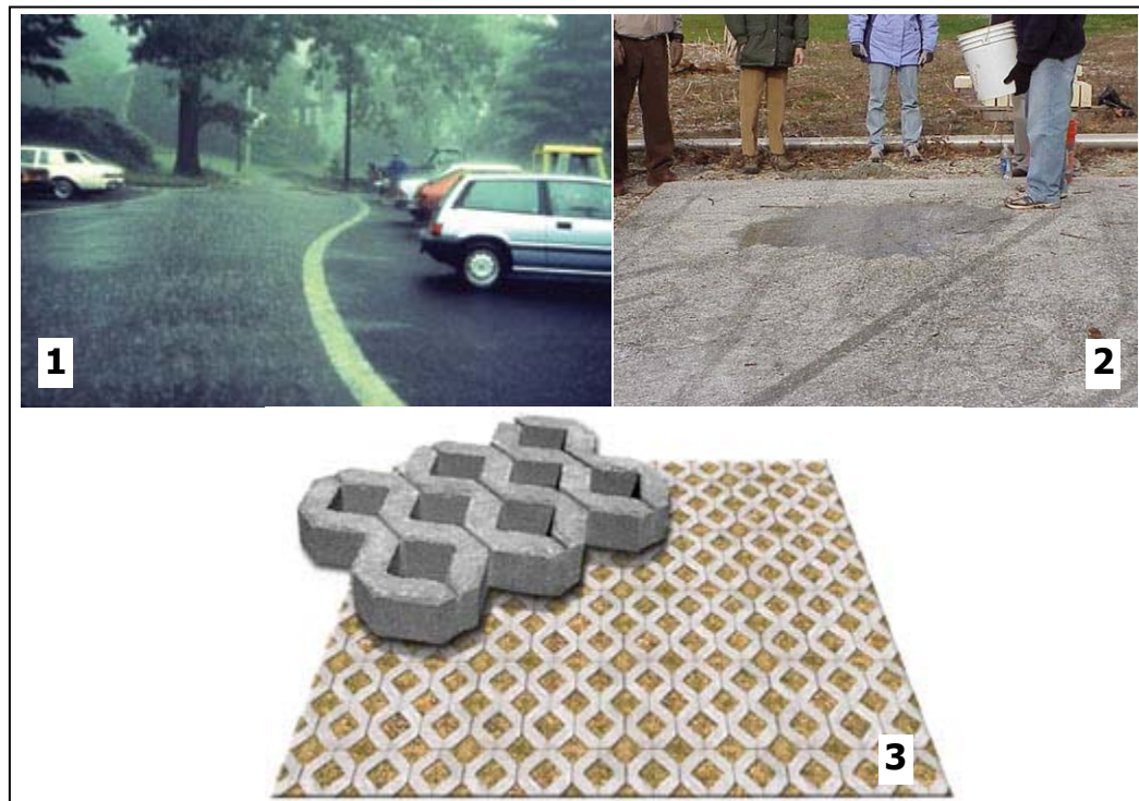
Figura 2.8. (1) Pavimento poroso em asfalto; (2) Pavimento poroso em concreto; (3) Pavimento permeável com blocos pré-moldados de concreto
