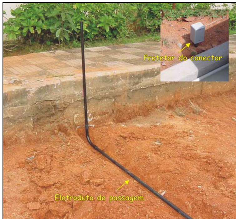
Figura 3.35. Instalação das guias de ondas para TDR e, no detalhe, o protetor do conector já instalado.
