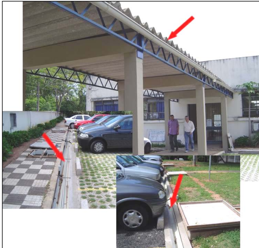
Figura 3.4. Calhas utilizadas para isolar o pavimento da contribuição do escoamento superficial.
