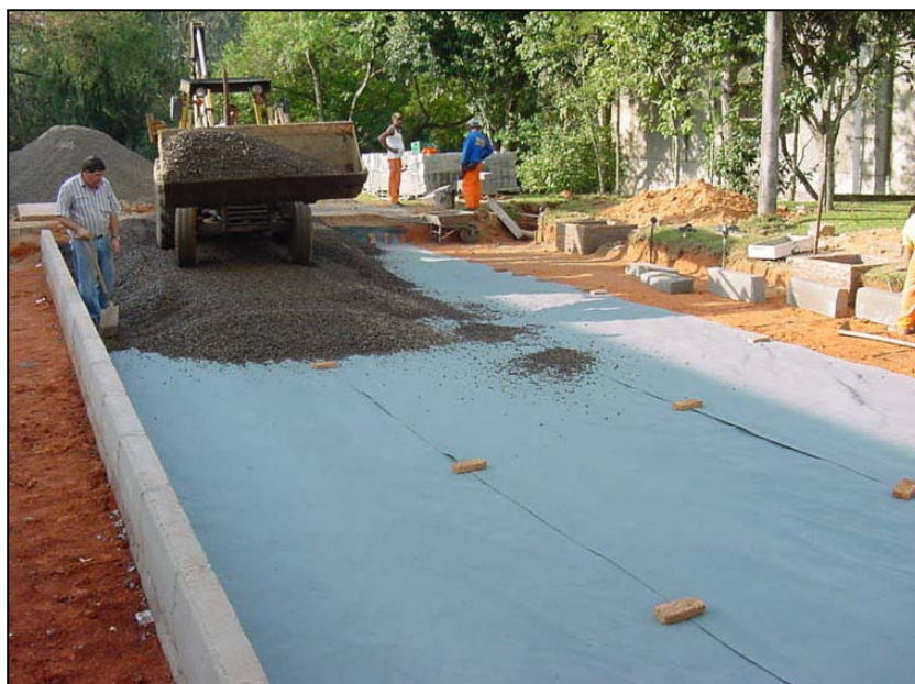
Figura 3.32. Assentamento da camada de brita.
