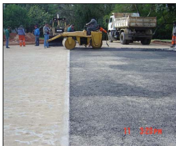
Figura 4.9. Transporte de areia dos blocos vazados para o asfalto pelo rolo compressor.
