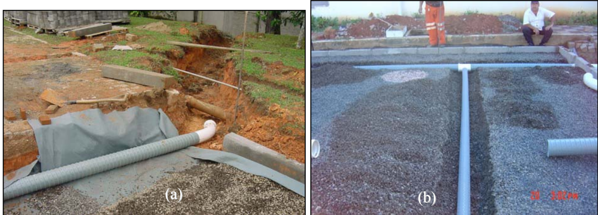
Figura 3.36. Assentamento dos drenos de fundo (a) e dos drenos extravasores (b).
