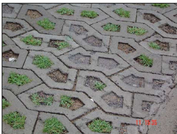
Figura 4.8. Preenchimento das partes vazadas dos blocos com água da chuva.
