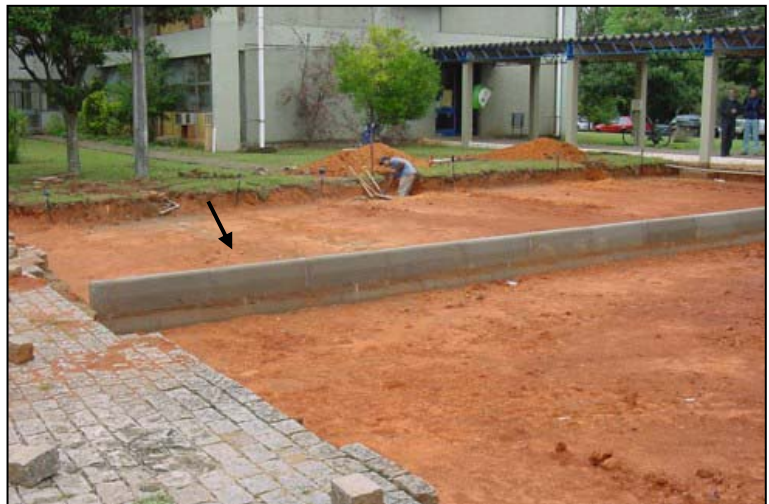
Figura 3.30. Septo enterrado para separação dos reservatórios.
