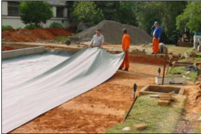
Figura 3.31. Assentamento do filtro geotêxtil.
