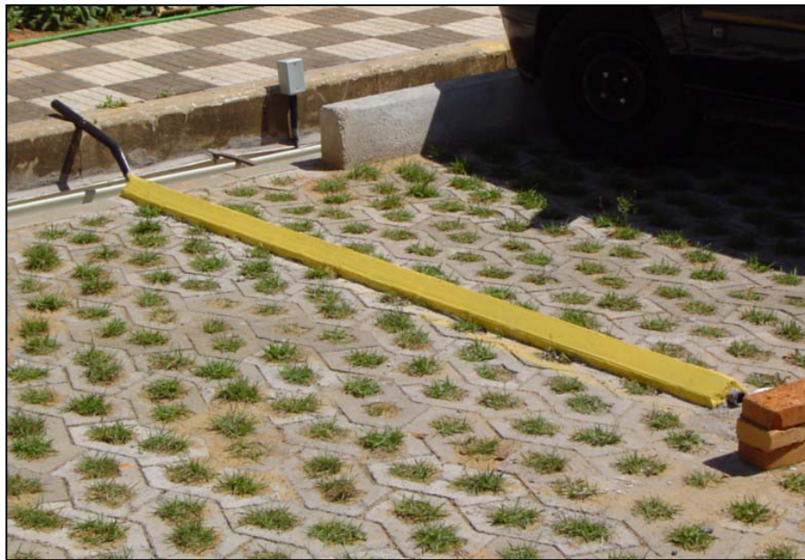
Figura 3.19. Poços de observação e protetor dos eletrodutos em concreto.
