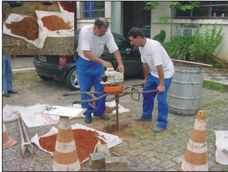
Figura 3.6. Sondagem de pontos para a caracterização do solo no estacionamento.
