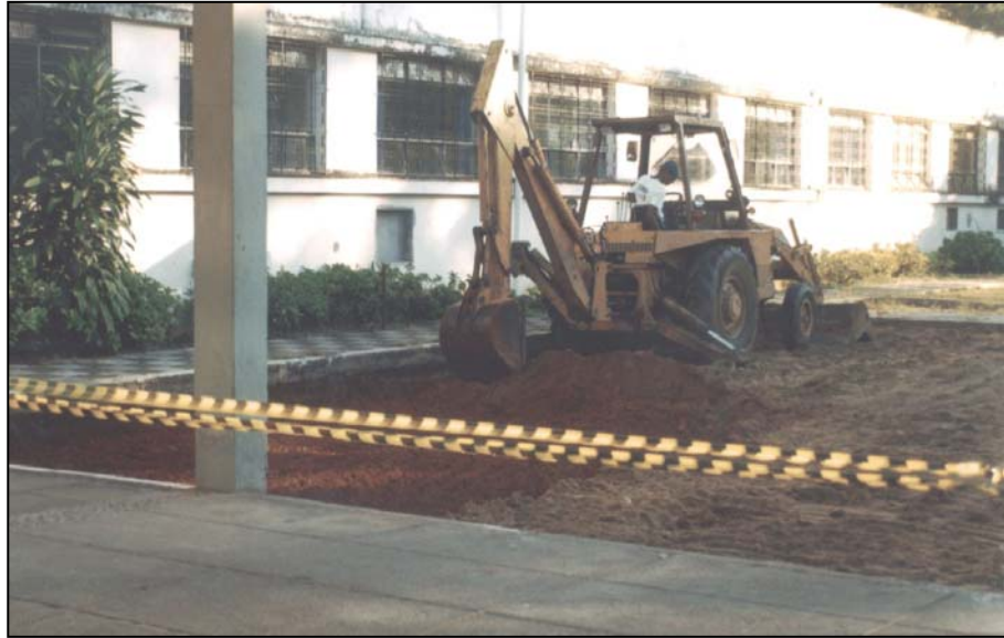
Figura 3.29. Escavação da camada reservatório com retro-escavadeira.
