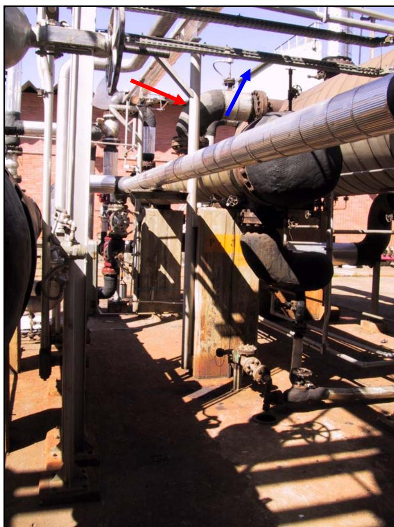
Figura 8-1 – Elementos estruturais a serem protegidos: coluna de seção circular (seta vermelha) e bandeja de cabos com seção retangular (seta azul)
