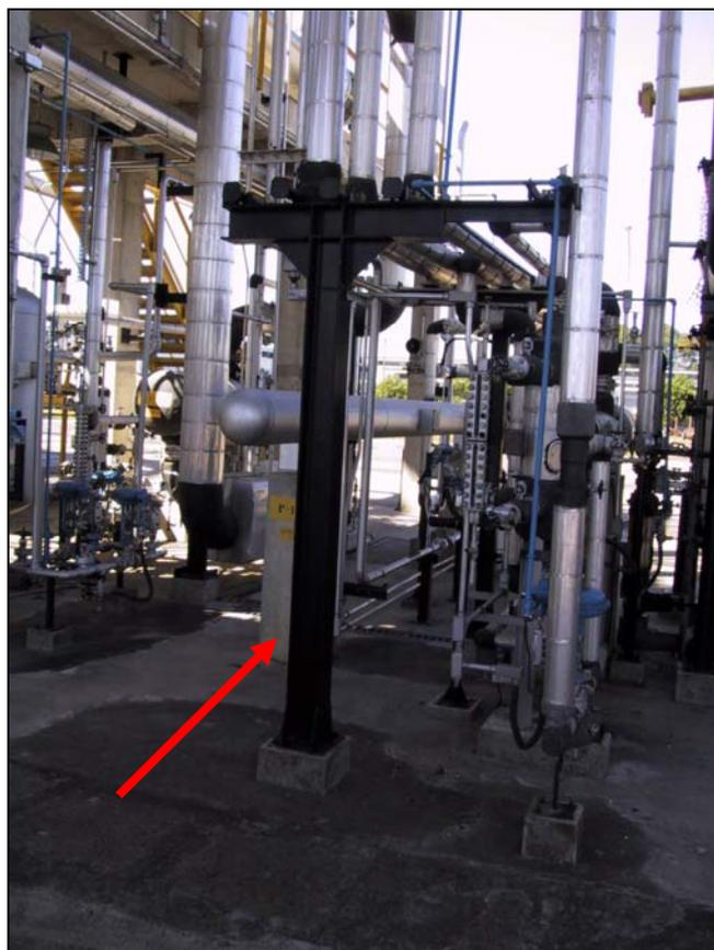
Figura 8-2 – Elemento estrutural a ser protegido: coluna de seção em I (seta vermelha)
