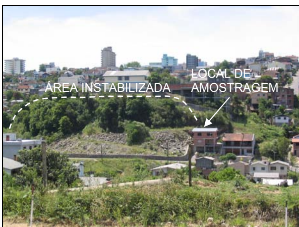
Foto 6.1: Vista do talude instabilizado no bairro Kaiser, Caxias do Sul/RS
