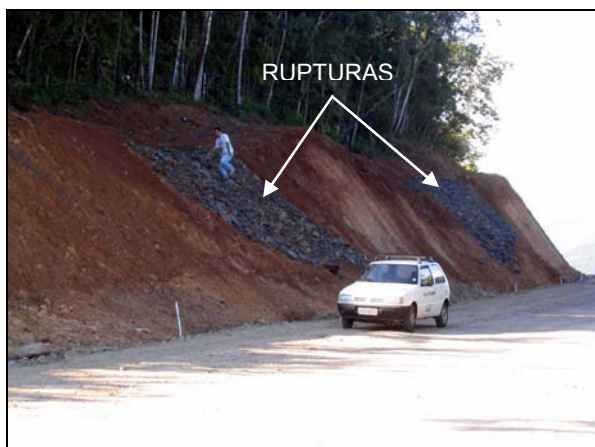
Foto 5.3: Local de amostragem dos solos km 119+120 superior e inferior
