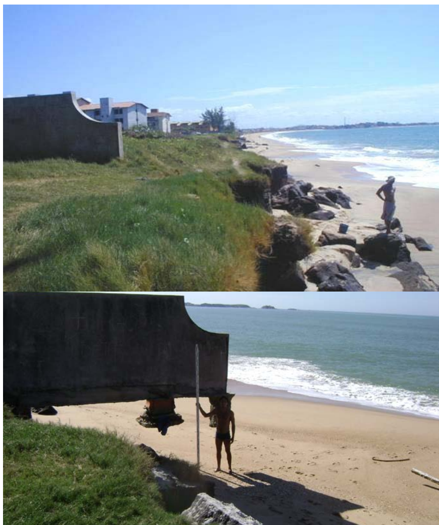
Figuras 30 e 31: Recuo da escarpa em 11 anos na praia do Abricó em Rio das Ostras. Foto superior de 1999 (Fonte: LINS-DE-BARROS, 2010) e inferior tirada em 2010 (Fonte: Arquivo pessoal).
