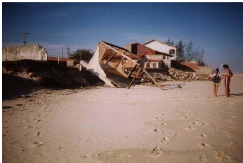
Figura 9 : Destruição de casas na orla da praia de Barra de Maricá após ressaca de 2001 (LINS-DE-BARROS, 2005)
