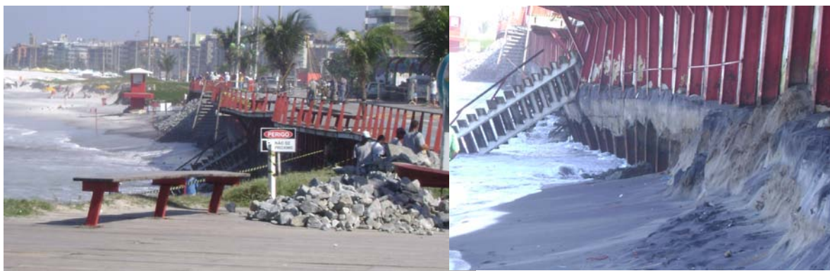
Figura 19 e 20: Calçadão destruído após evento extremo em junho de 2010. Praia do Forte em Cabo Frio. (Fonte: Arquivo pessoal)
