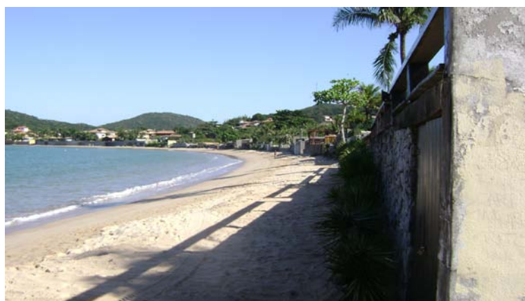
Figura 24: Muros dentro do perfil ativo da praia. Praia da Ferradura, Búzios. (Fonte: Arquivo pessoal)
