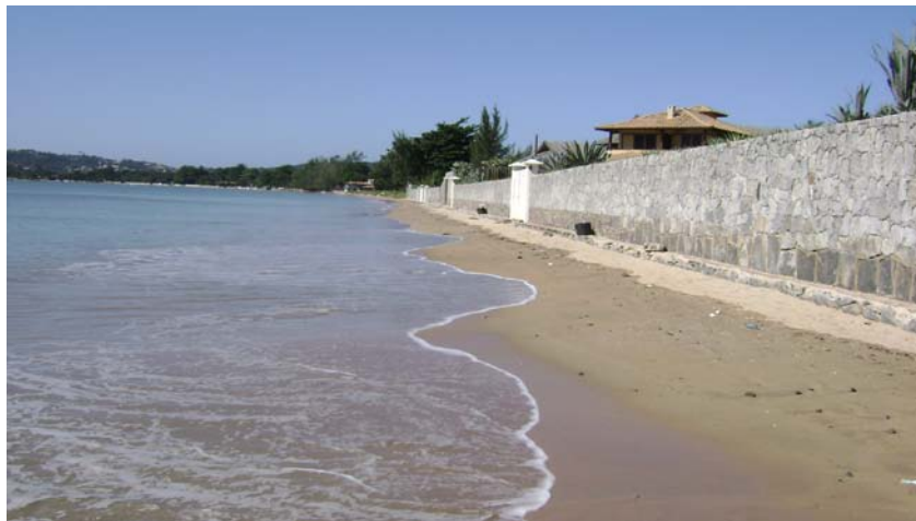
Figura 22: Muro dentro do perfil ativo da praia. Praia de Manguinhos, Búzios. (Fonte: Arquivo pessoal)
