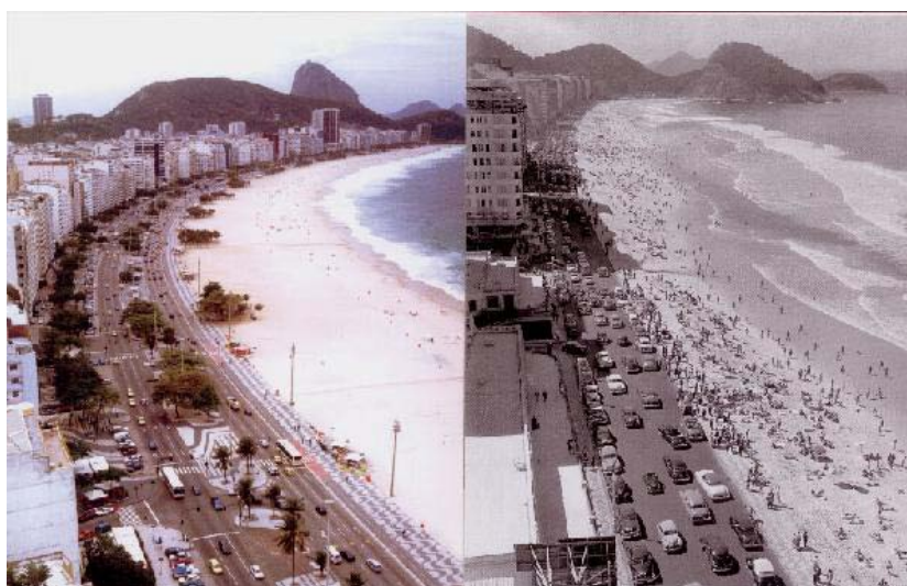
Figura 1: Praia de Copacabana antes (direita) e depois (esquerda) do projeto de alimentação artificial (Fonte: Notas de Aula TOLDO Jr.).
