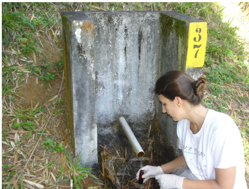
Figura 14. Amostragem de água dos drenos.
