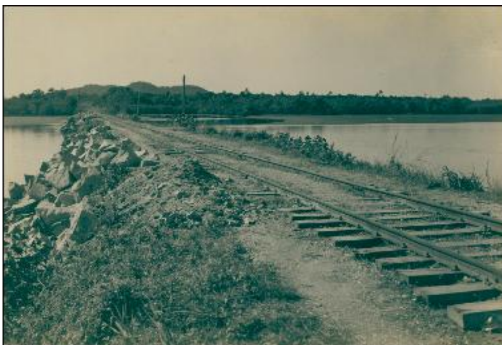
Figura 3-1: Fotografia mostrando o aterro entre a Ilha de São Francisco do Sul e a Ilha João Dias.
