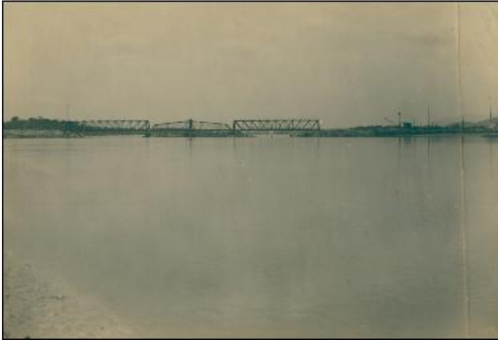
Figura 3-2: Fotografia mostrando a ponte metálica construída entre a Ilha João Dias e o continente.
