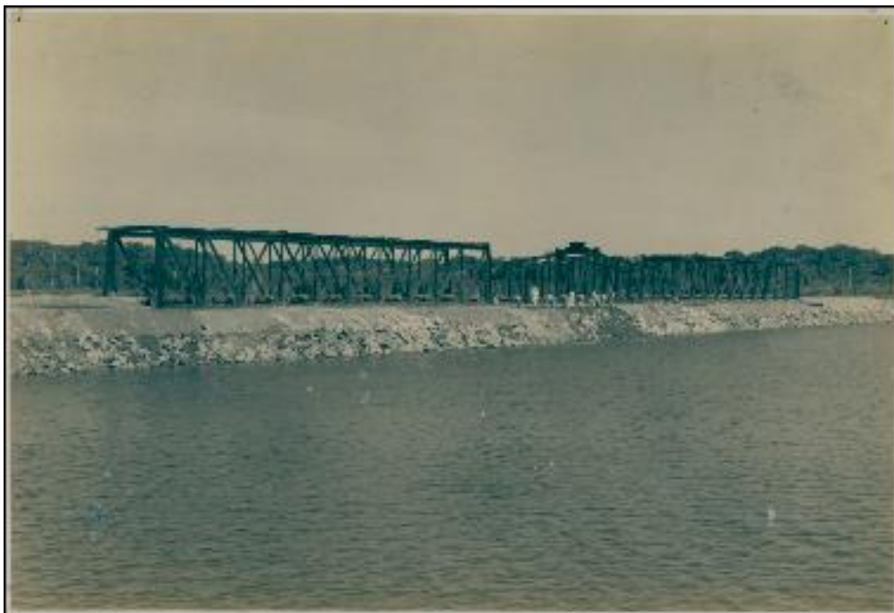
Figura 3-5: Fotografia mostrando a conclusão do fechamento dos vãos da ponte em 1935.
