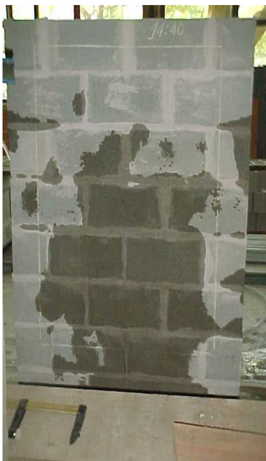
Figura 51: ensaio de absorção de água pelo método empregado pela CIENTEC - bloco de concreto - corpo de prova 3 - tempo de ensaio: 5 minutos da 1 a . etapa
