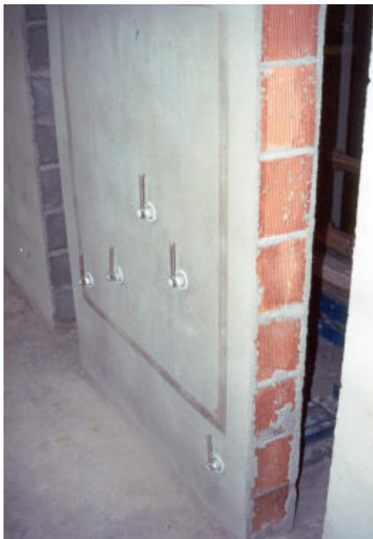
Figura 26: avaliação de estanqueidade pelo método do cachimbo – vista lateral
