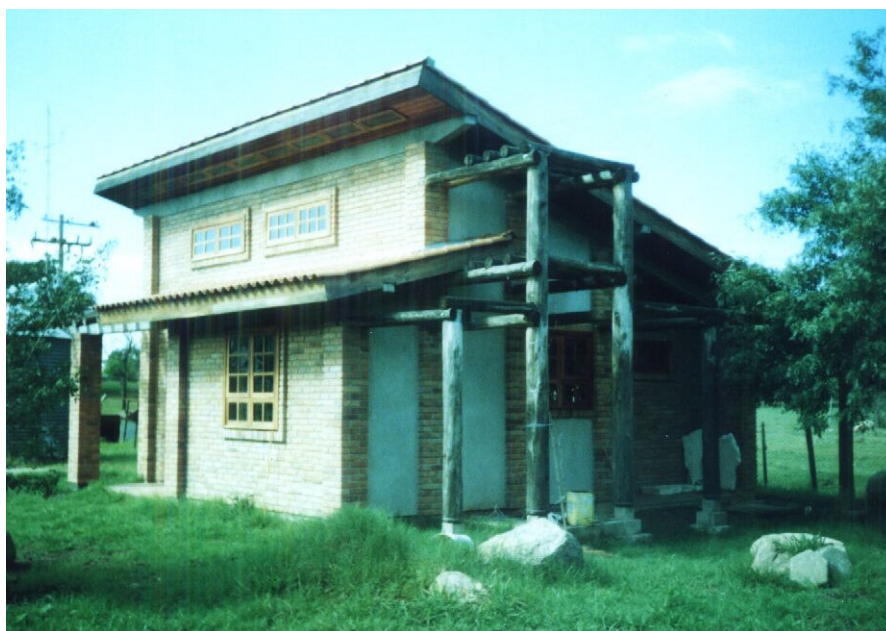
Figura 11: vista noroeste do protótipo de habitação mais sustentável
