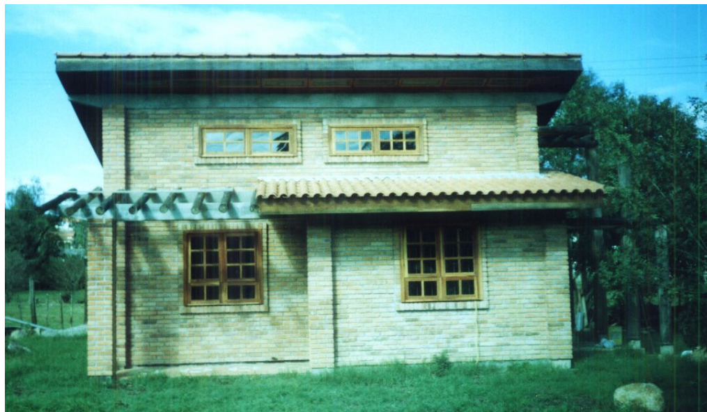
Figura 9: vista norte do protótipo de habitação mais sustentável
