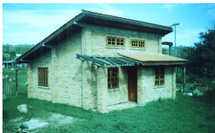
Figura 2: vista nordeste do protótipo de habitação mais sustentável
