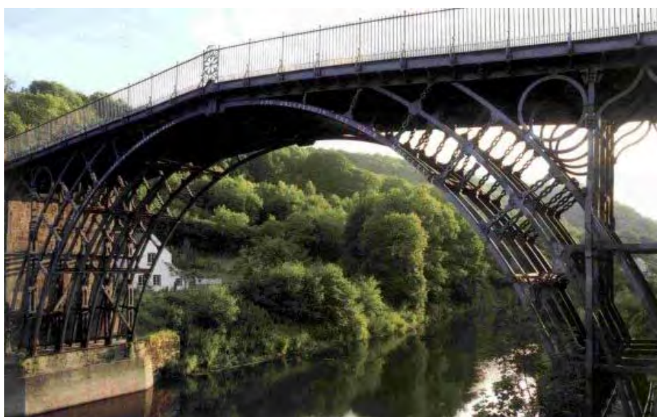
Figura 15 - Ponte de Coalbrookdale
