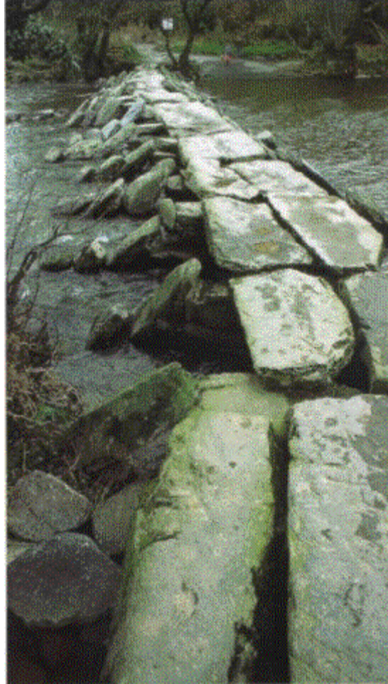
Figura 5- Ponte “Tarr Steps”, na Inglaterra.
