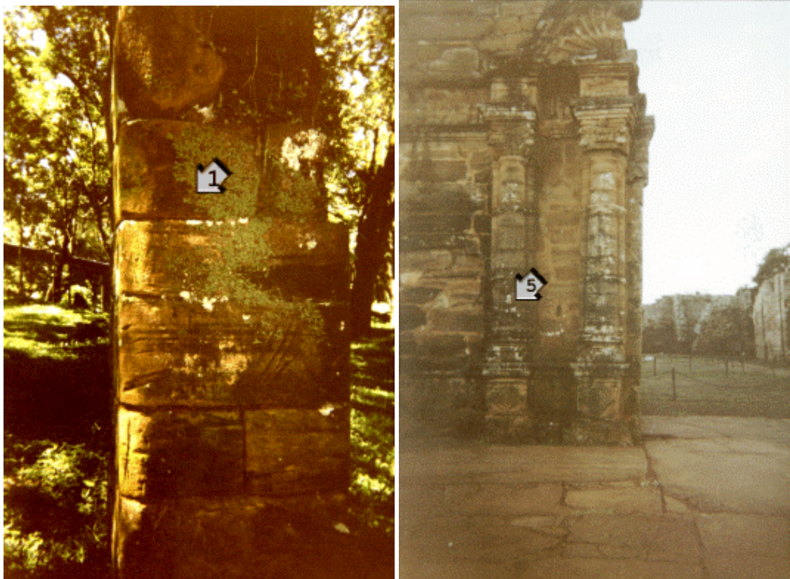
Figura 26 (esq) amostra [1] retirada de uma coluna das viviendas em Loreto. (dir) amostra [5] retirada da parede exterior da parte frontal do templo em San Ignacio.
