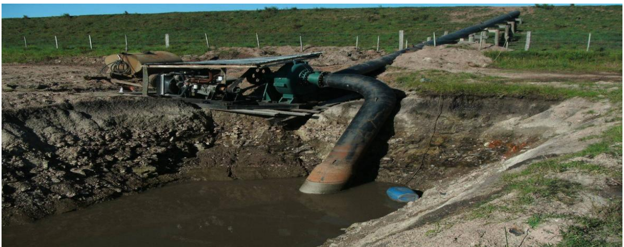
Bombeamento para canal de irrigação – Estância “C”. Fotografia: Valeriano Alan Jardim de Moraes (autor).
