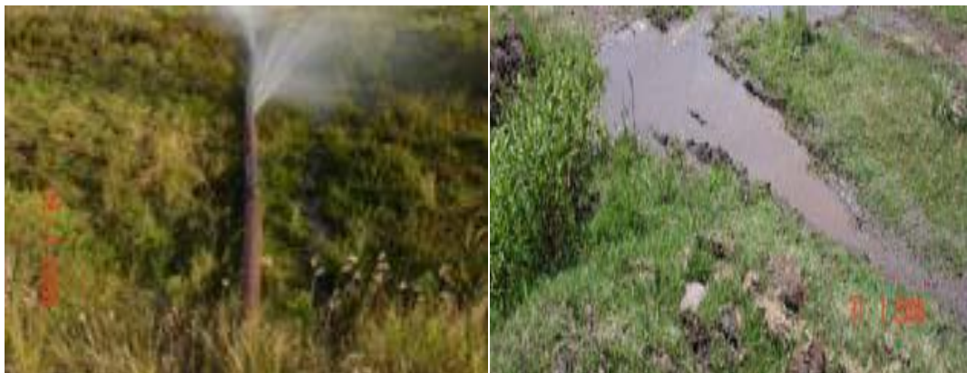
Figura 13: Vazamentos nos sistemas de irrigação Fonte: Álbum da autora, 2011
