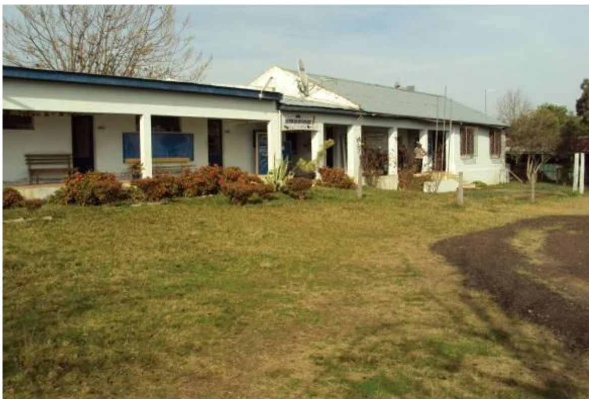
Figura 01 – Fachada da E.M.E.F. João Tubino.
