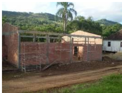
Figura14: Salão novo de Colônia Itagiba em construção Fonte: Janice Sperb, 2010
