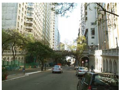
Fig. 3.5 - Viaduto Otávio Rocha. Fonte: Internet.
