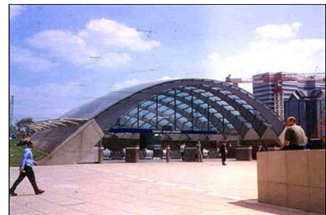
Fig. 2.20 - Estação de metrô Canary Wharf, Jubilee Line, Londres. Foto: Lineu Castello.
