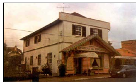
Fig. 5.26 - Fachada “alpina” sobreposta. Foto: Kênia do Espírito Santo.
