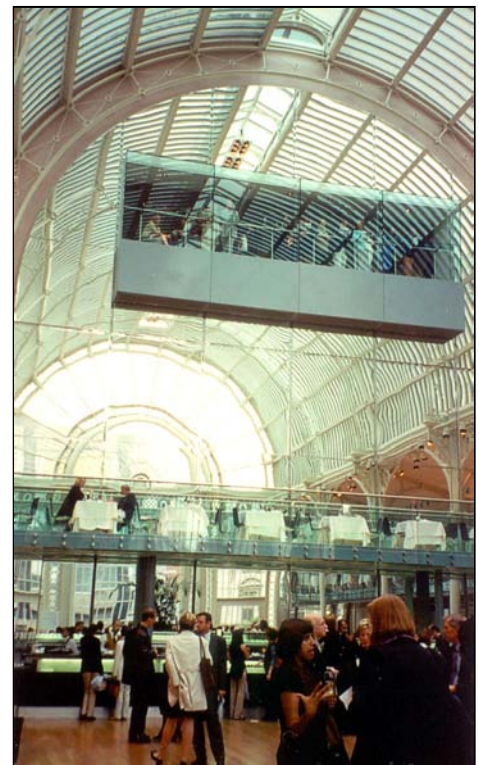
Fig. 2.16 - Covent Garden Opera House Foto: Iára Castello.
