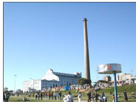
Fig. 5.1 - Usina do Gasômetro, Porto Alegre. Foto: Lineu Castello.
