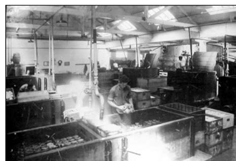
Fig. 5.55 - antiga fábrica Renner. Fonte: Foto ampliada exposta no DC-Navegantes.
