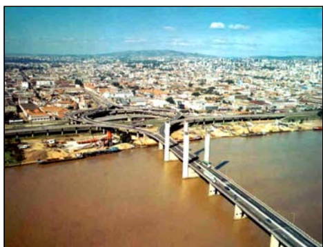
Fig. 5.53 - Complexo de viadutos no acesso da ponte. Foto: Henrique Amaral Studio.
