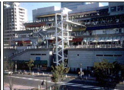
Fig. 3.10 - Tóquio: shopping "Decks". Foto: Lineu Castello.
