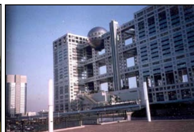
Fig. 3.13 - Tóquio: complexo da Fuji TV. Foto: Lineu Castello.
