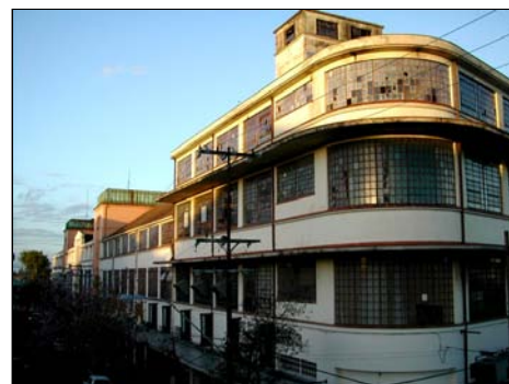
Fig. 5.56 - Prédio reciclado no DC-Navegantes. Foto: Lineu Castello.
