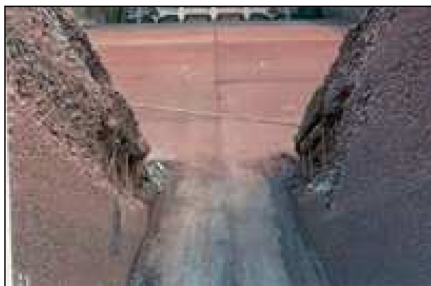
Figura 6 – Danos ocorridos em estruturas hidráulicas: a esquerda erosão por cavitação nos blocos de dissipação da UHE Porto Colômbia (ICOLD/CBDB, 2002) e a direita a bacia de dissipação da UHE Salto Grande (Lopardo et al. , 2006)
