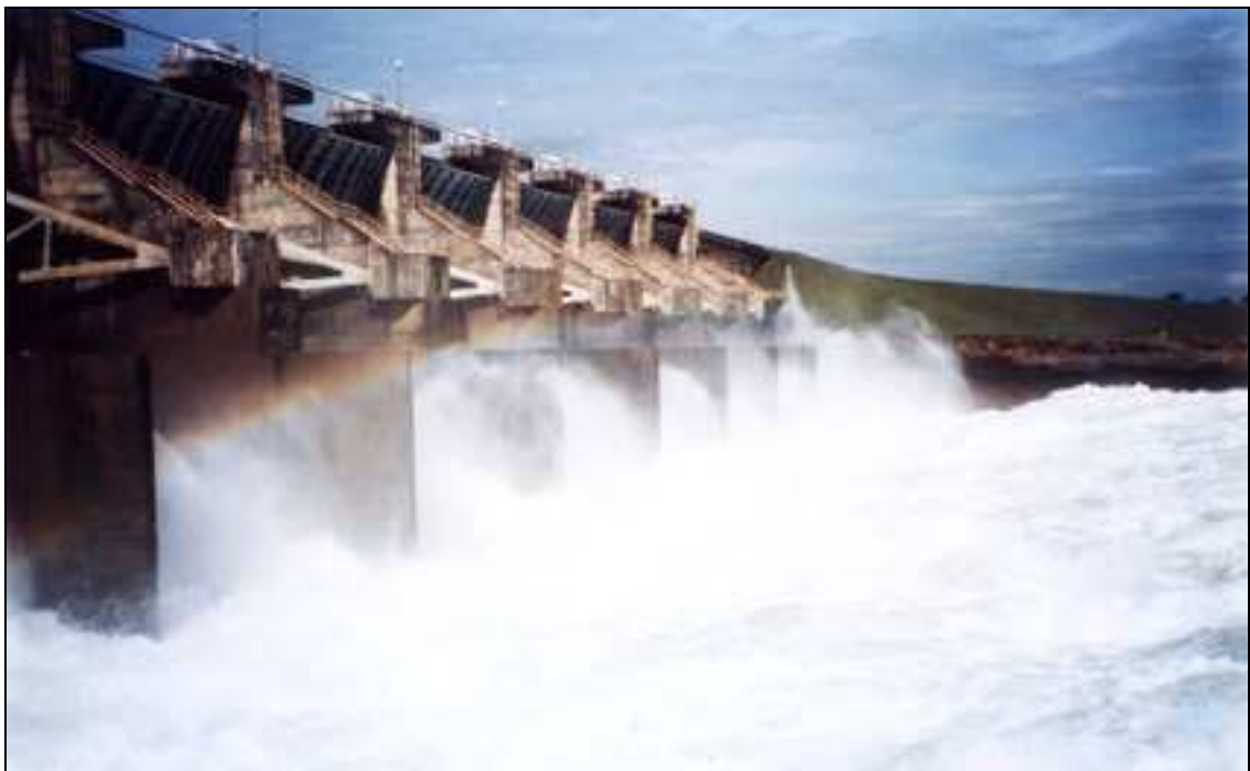
Figura 5 – Ressalto hidráulico formado na bacia de dissipação da UHE de Porto Colômbia, vazão de 4000 \text{ m}^3/\text{s} e número de Froude ( Fr_1 ) igual a 3,88. Fonte: Marques et al. (1999).
