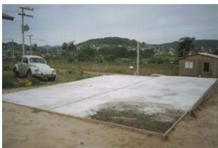
Figura 28: Radier pronto para a montagem
