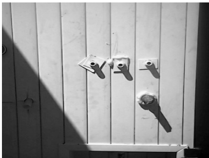
Figura 33: Instalações embutidas nas paredes
