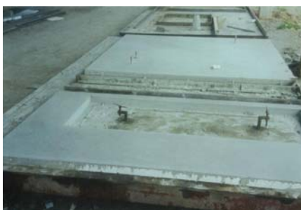
Figura 13: Painéis concretados
