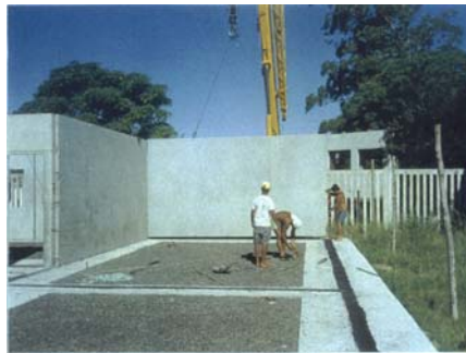
Figura 14: Fundação e preparação para contrapiso
