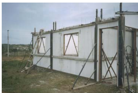
Figura 30: Concretagem das paredes
