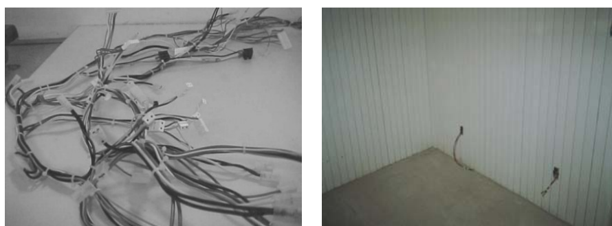
Figura 32: Chicotes antes da colocação e já colocados nos eletrodutos
