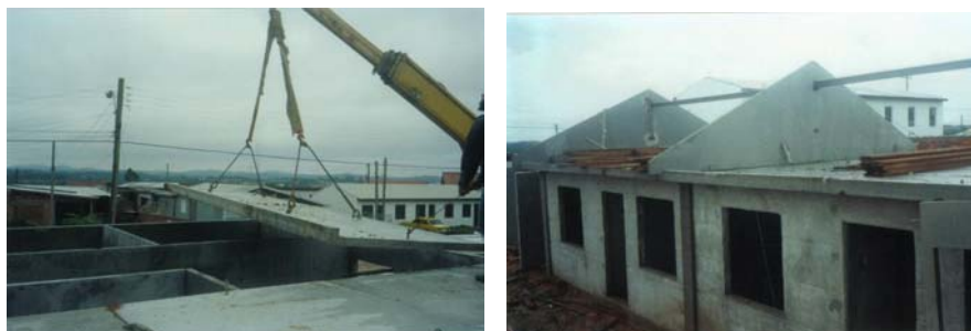
Figura 17: Montagem das lajes e execução do telhado
