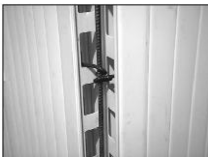
Figura 29: Detalhe de armadura do encontro de paredes
