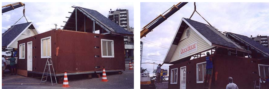
Figura 27: Execução de telhado pré-montado
