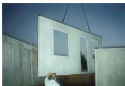
Figura 15: Posicionamento de painel de fachada frontal
