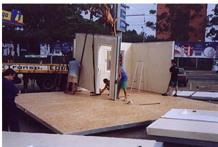
Figura 26: Execução de divisória interna
