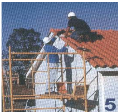
Figura 40: Execução da cobertura
