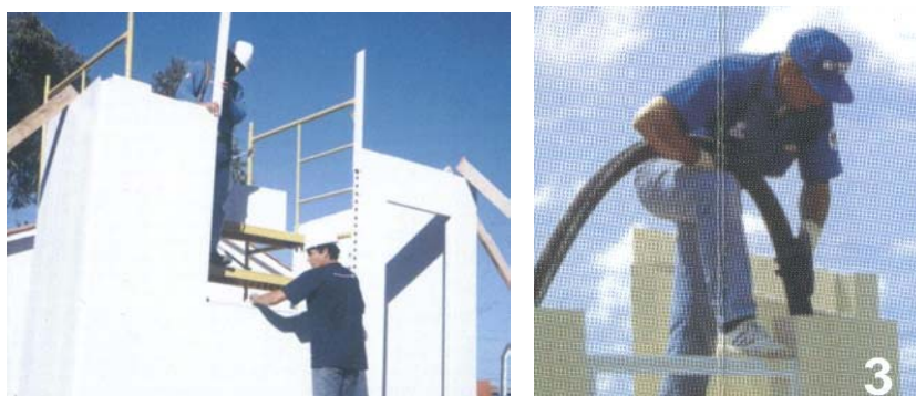
Figura 39: Montagem e concretagem dos perfis
