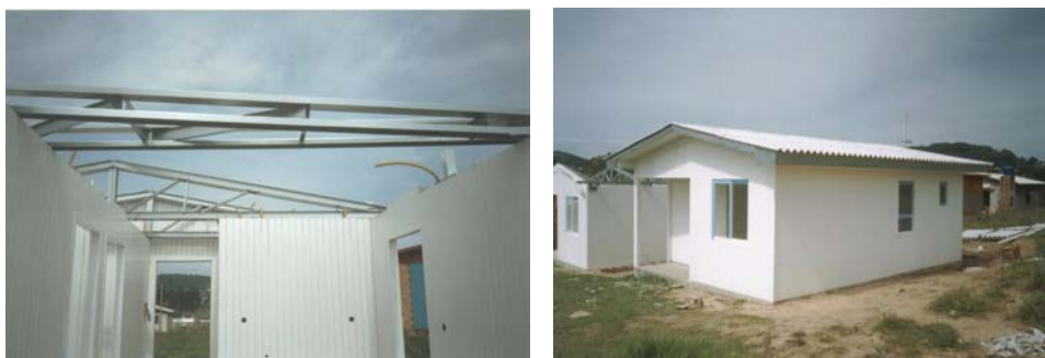
Figura 34: Execução da estrutura do telhado e casa pronta
