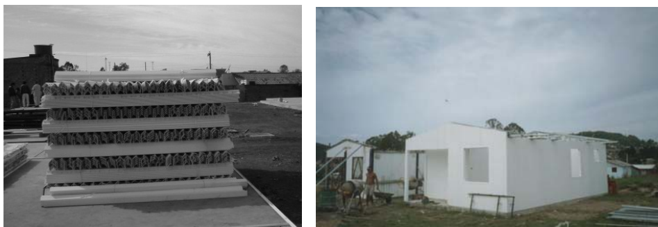
Figura 31: Kit correspondente às paredes de uma casa e envelope montado
