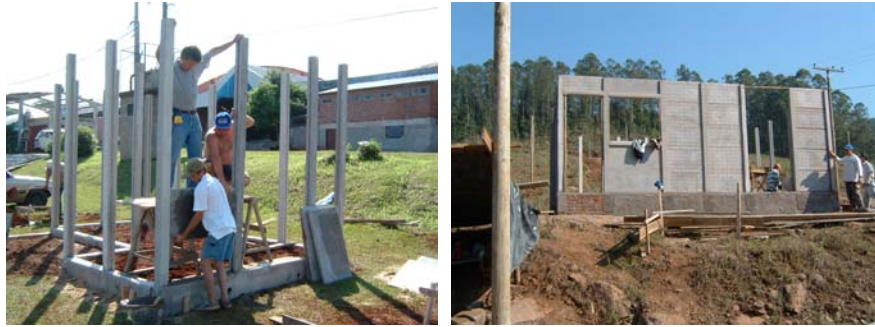
Figura 10: Execução do envelope
