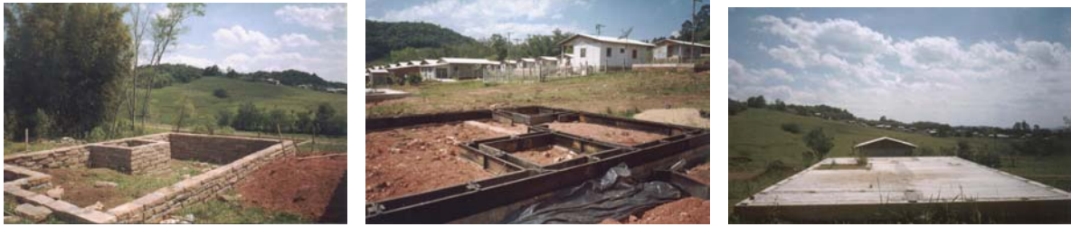
Figura 19: Etapas de execução das fundações
