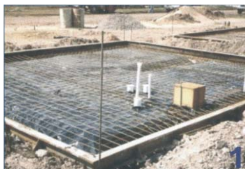
Figura 37: Preparação para concretagem de radier
