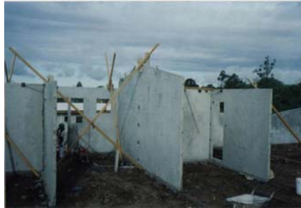
Figura 16: Montagem de painéis de divisórias internas
