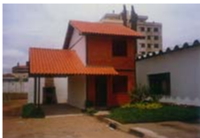
Figura 43: Vista da residência pronta
