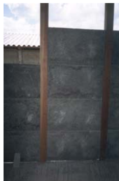
Figura 21: Execução do envelope
