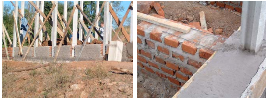
Figura 9: Execução da estrutura e viga de baldrame
