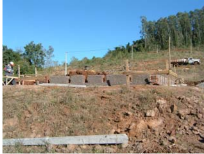
Figura 8: Fundação direta convencional em alvenaria de tijolos
