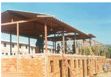
Figura 42: Execução da alvenaria
