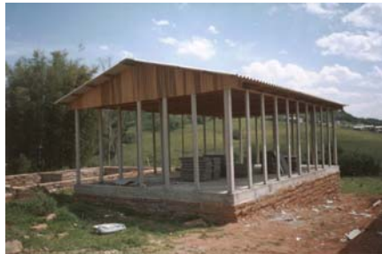
Figura 20: Estrutura e cobertura pronta
