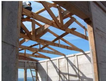
Figura 12: Montagem da estrutura do telhado e cobertura pronta
