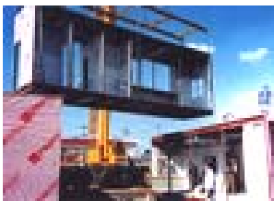
Figura 24: Transporte de uma edificação semi montada
