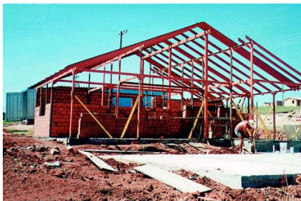
Figura 41: Montagem da estrutura da edificação
