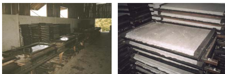
Figura 18: Formas metálicas e placas concretadas
