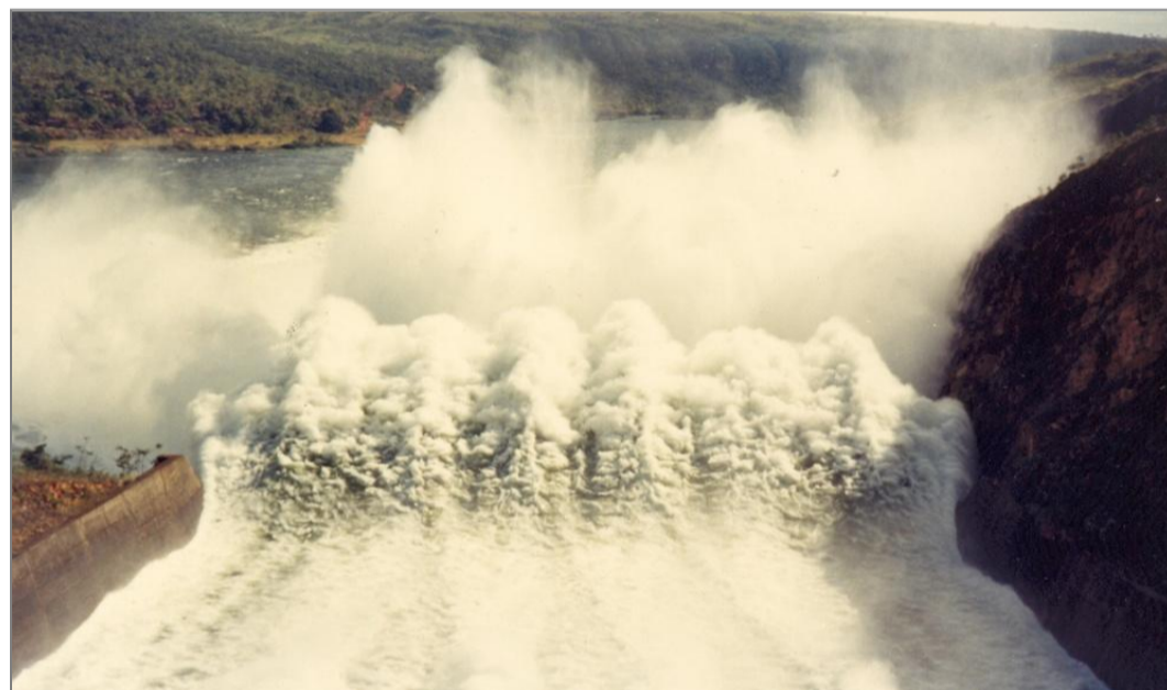
Salto Esquí da Hidrelétrica Luis Carlos Barreto de Carvalho (Protótipo)
