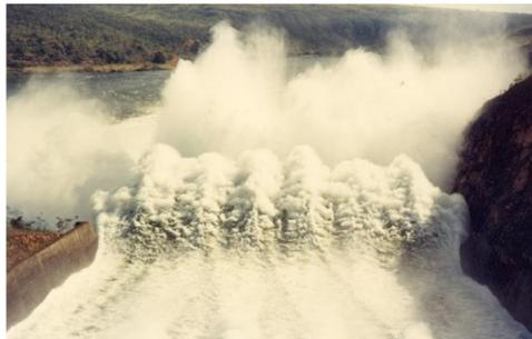
Formação do jato no vertedouro salto esquí da UHE Estreito
