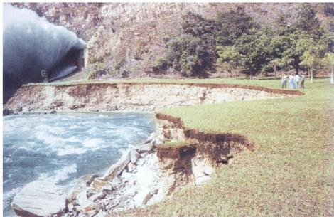
Erosão provocada por correntes de retorno na UHE Estreito (CBDB, 2002).
