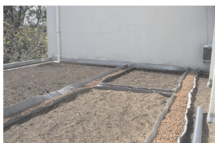
Figura 9: Execução do projeto Telhado Vivo terraço prédio 5 - implantação do substrato. Fonte: USE
