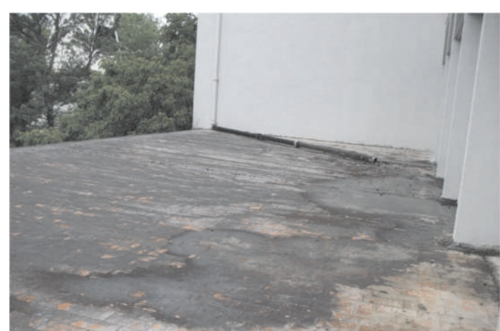
Figura 8: Terraço prédio 5 - situação antes de execução. Fonte: USE
