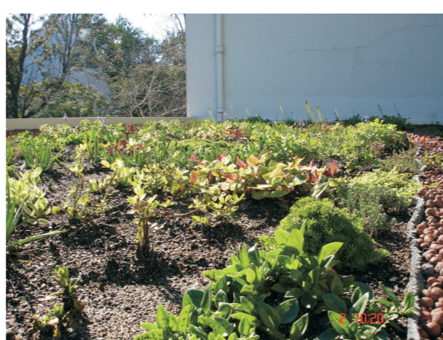
Figura 10: Conclusão -Telhado Vivo terraço prédio 5
