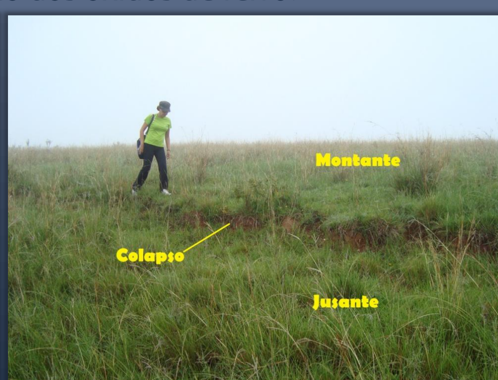
Figura 5: Degrâu de abatimento localizado no Município de Manoel Viana, RS. Fotografia: Felipe de Sousa Gonçalves (2009).
