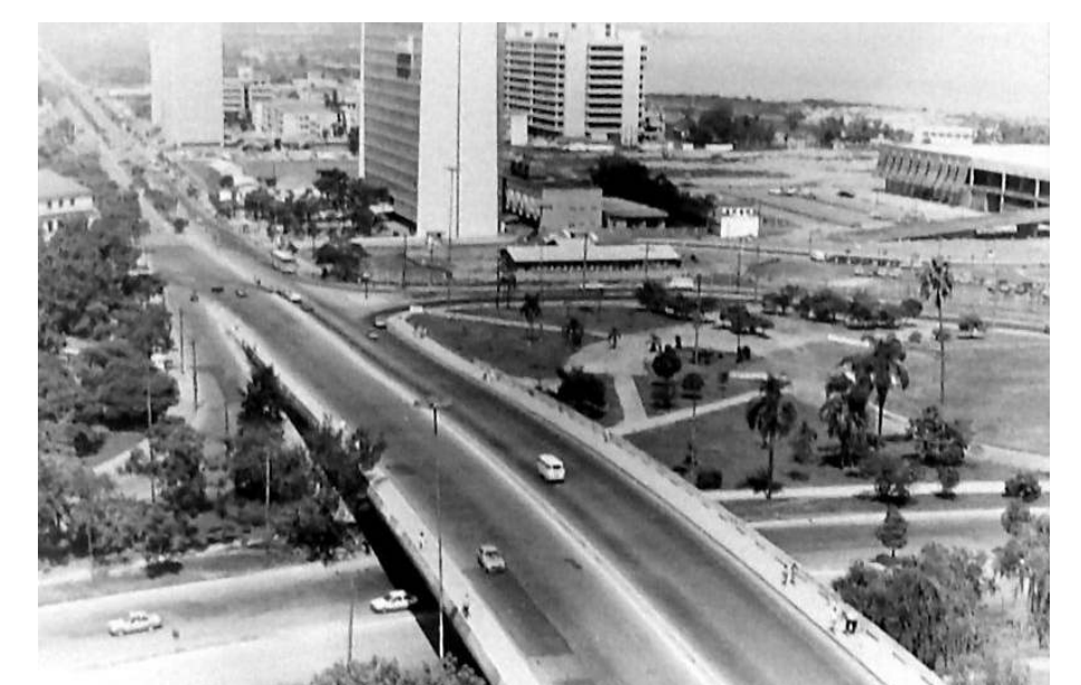
Viaduto Açorianos e Av. Loureiro da Silva - Década de 1980 Fonte: www.prati.com.br
