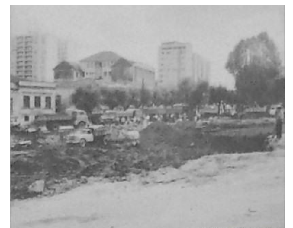
Construção da Elevada da Conceição - Década de 1970 Fonte: www.prati.com.br
