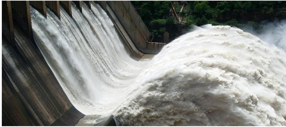
Vertedouro com salto de esquí – UHE Srisaïlam, Índia
