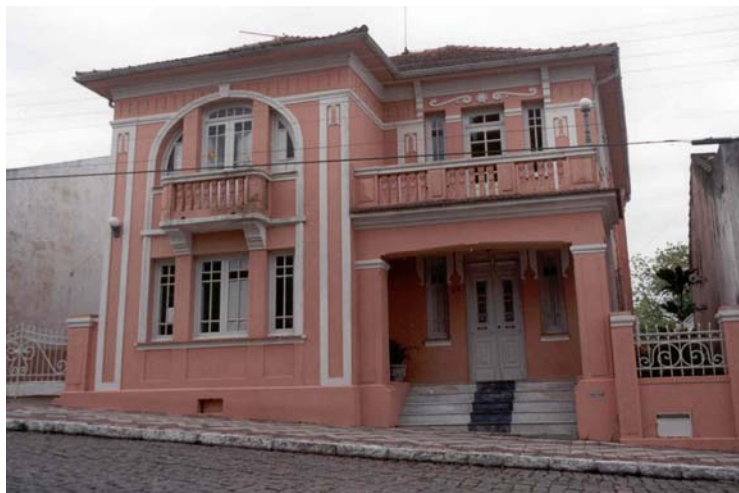
Figura 38 - Residência do Sr. Sidronio Cardoso Fonte: Foto de Lidiane Corrêa Ensslin
