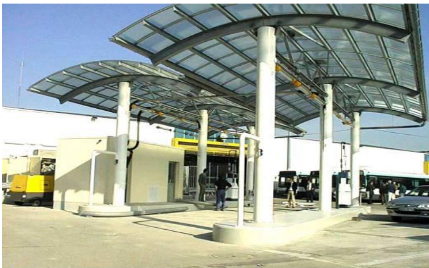
Figura 8 Posto de Abastecimento Público
