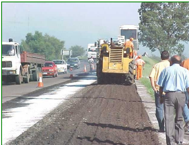
Figura 3.27 - Compactação Camada Reciclada com Rolo Tipo Pé-de-Carneiro
