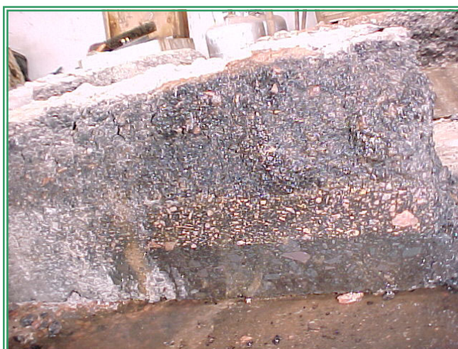
Figura 4.15 – Detalhe da Camada Reciclada
