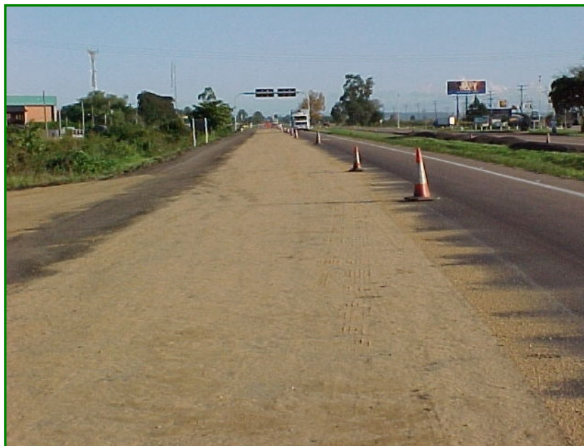
Figura 3.28 - Capa Selante após Reciclagem e antes da Capa Asfáltica
