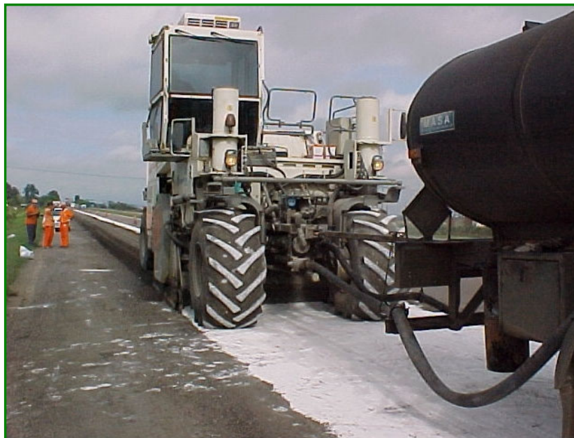
Figura 3.26 - Recicladora WR-2500 – Wirtgen reciclando
