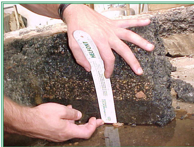
Figura 4.14 - Detalhe da Espessura da Capa Asfáltica
