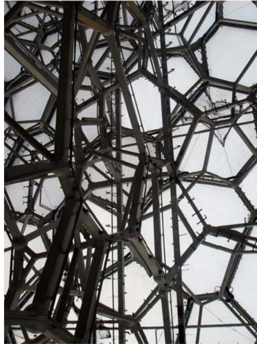
Figura 48: Foto da estrutura do Cubo D'água.
