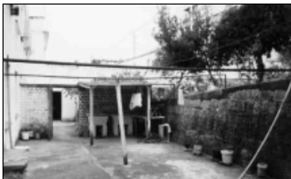
Figura 86: Área 4B (tanques e varal em área de serviço )
