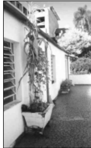
Figura 82: Área 2B (tanque utilizado como floreira)
