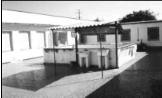
Figura 81: Área 2B (tanques e varal no terraço)
