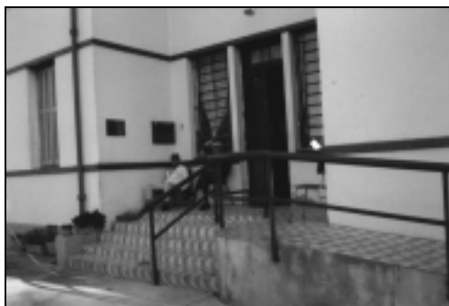
Figura 28: Instituição G2 – presença de corrimão e de rampa junto ao acesso principal.
