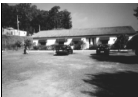
Figura 11: Instituição E2 – estacionamento situado na frente do lote
