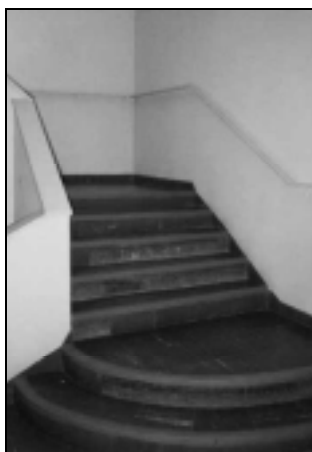
Figura 49: Escada de acesso aos dormitórios do 2º piso e ao terraço (Instituição B)
