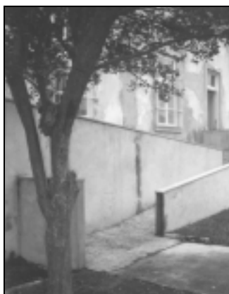
Figura 27: Instituição E1 – rampa de acesso ao pátio
