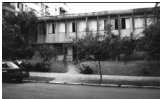
Figura 46: Entrada principal e fachada da edificação principal (Instituição B)
