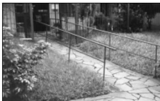
Figura 29: Instituição G1 – rampa com corrimão junto ao acesso principal.
