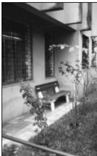
Figura 80: Área 1B (banco junto à entrada da edificação)
