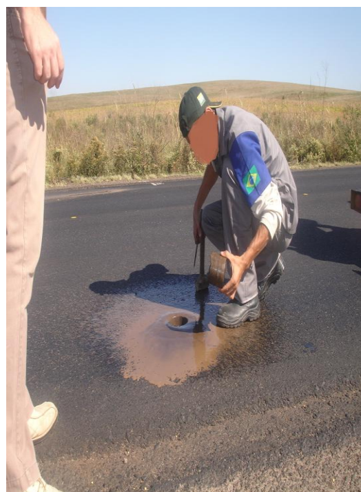
b) retirada de corpo de prova do revestimento asfáltico, após operação da sonda rotativa.
