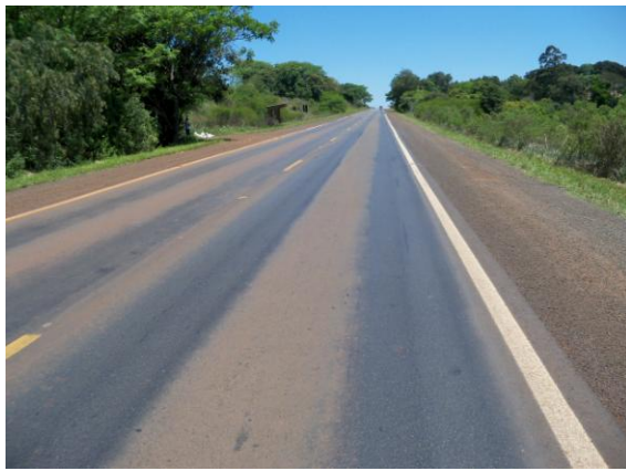
(a)BR-285/RS km 532, exsudação nas trilhas de roda;
