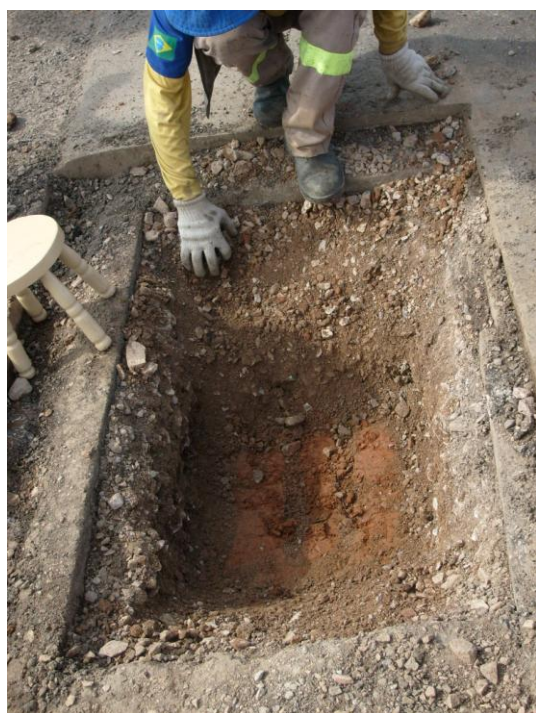
a) abertura de trincheira no pavimento no bordo da faixa de rolamento;
