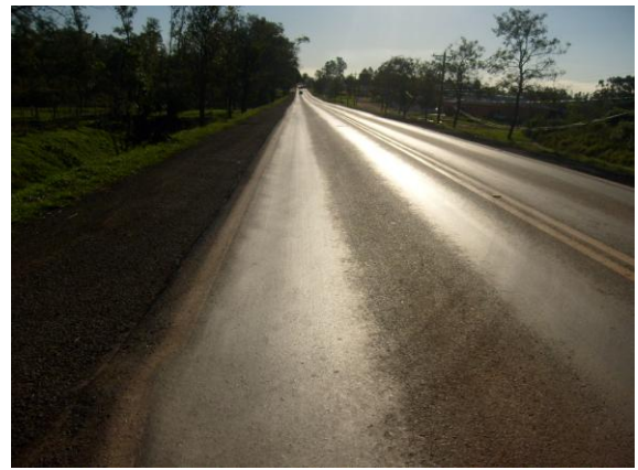
(b)BR-285/RS km 670, exsudação nas trilhas de roda com aparência brilhosa em função da claridade;
