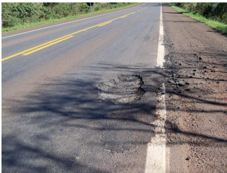
Figura 04: exemplo de panela ou buraco. BR-285/RS (município de Panambi)
