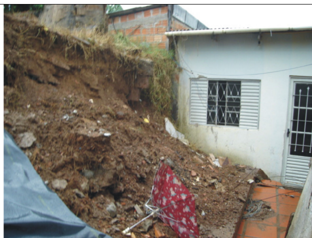
Figura 20: Registro de escorregamento. Rua Costa Gama 190.
