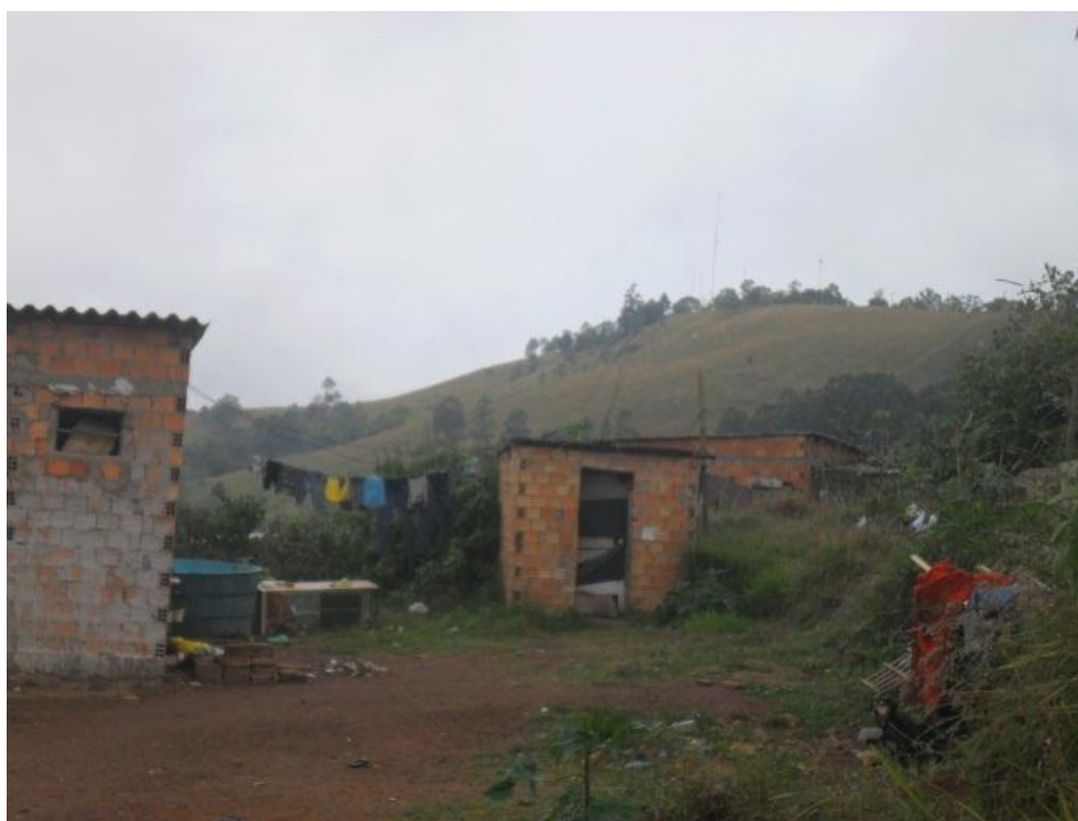
Fotografia 15 – Encosta superior da UP 5 – Baixo padrão construtivo das moradias – Morro da Polícia - sub-bacia do arroio Moinho - Porto Alegre/RS. Fonte: Rafael Lopez (27.05.2011).
