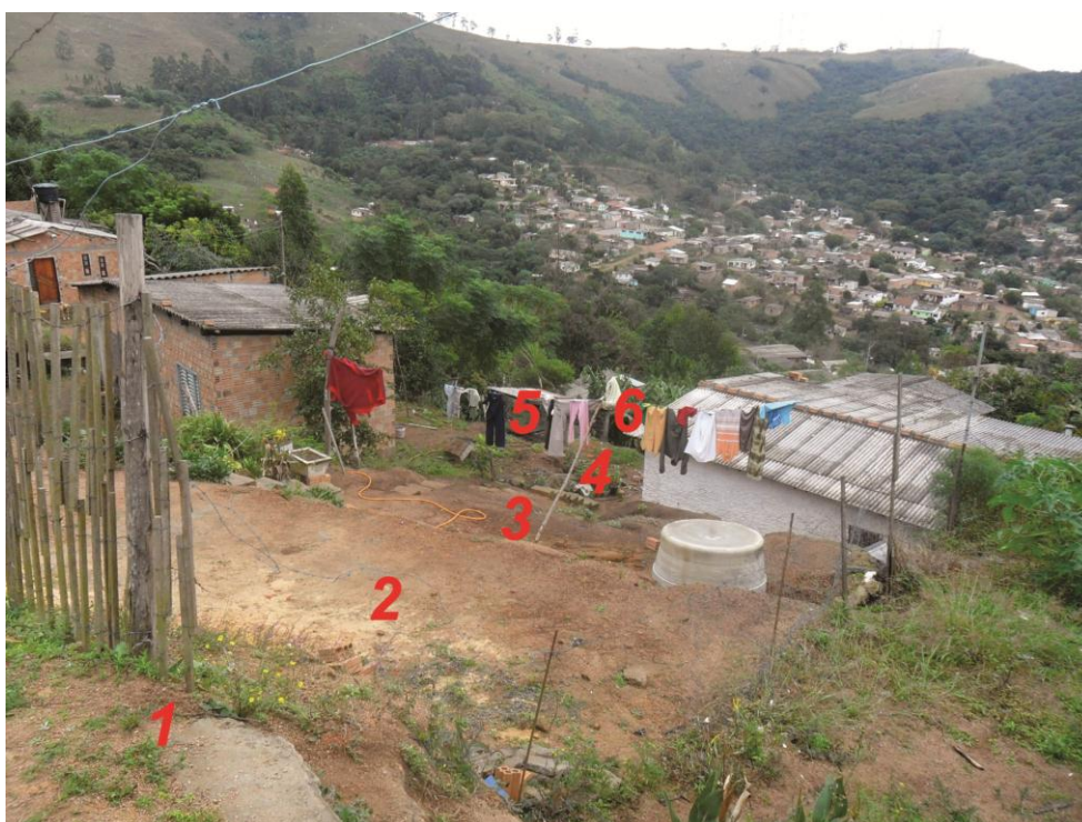
Fotografia 16 – Encosta superior da UP 5 – Sucessivos patamares de corte e aterro da encosta – Morro Pelado - sub-bacia do arroio Moinho - Porto Alegre/RS. Fonte: Rafael Lopez (27.05.2011).
