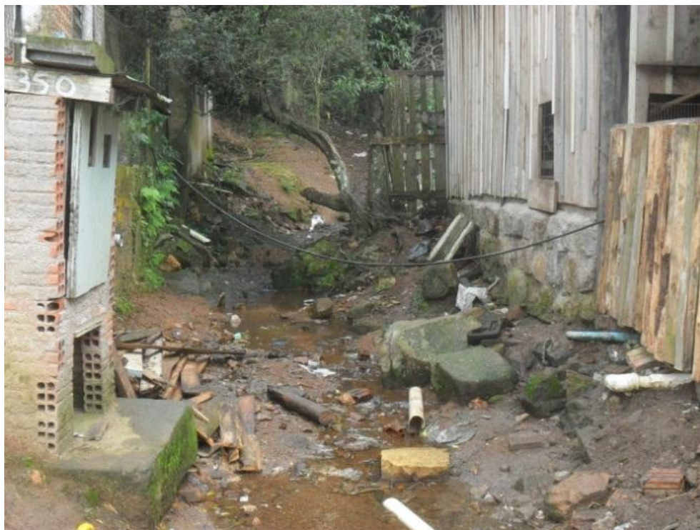
Fotografia 21 – Encosta superior da UP 4 – Ocupação sobre a drenagem natural – Morro Pelado - sub-bacia do arroio Moinho - Porto Alegre/RS. Fonte: Rafael Lopez (27.05.2011).
