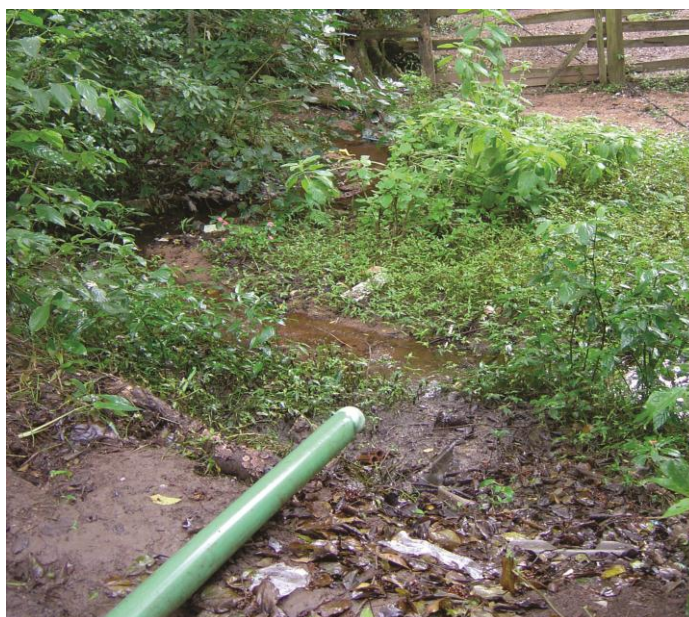
Fotografia 24 – Cano de esgoto direcionado para o arroio que atravessa o lote – Morro Pelado - sub-bacia do arroio Moinho - Porto Alegre/RS. Fonte: Rafael Lopez (27.05.2011).
