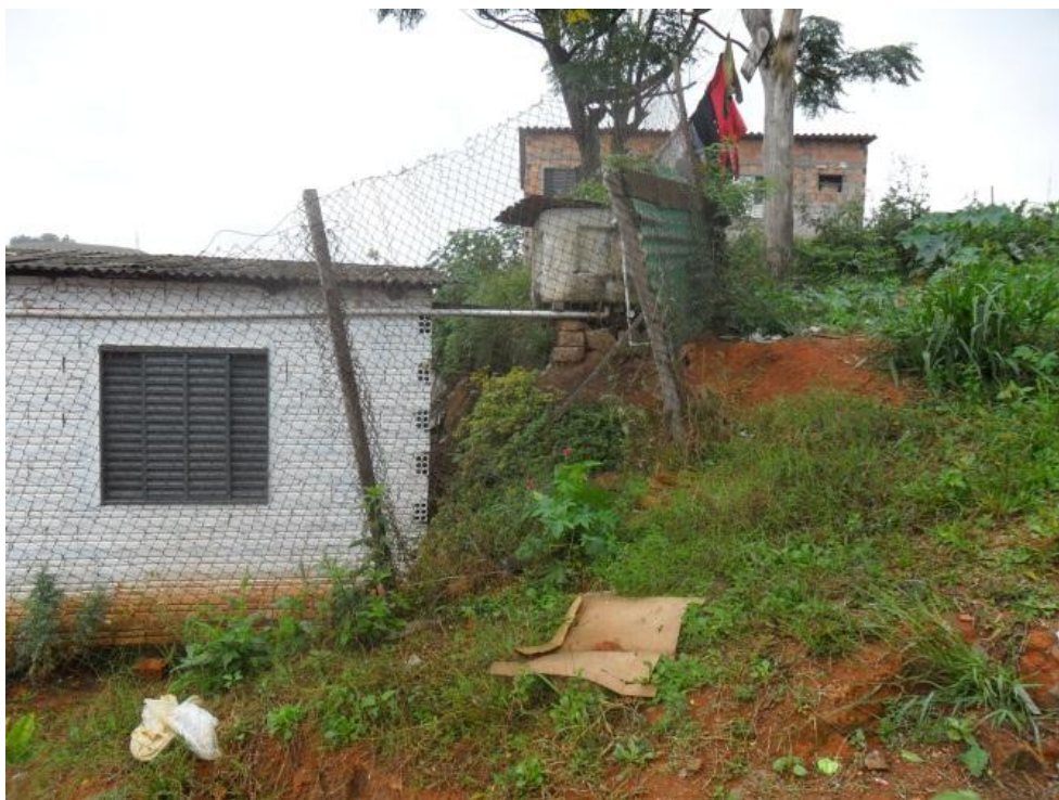
Fotografia 17 – Encosta superior da UP 5 – Corte e aterro da encosta – Morro da Polícia - sub-bacia do arroio Moinho - Porto Alegre/RS. Fonte: Rafael Lopez (27.05.2011).
