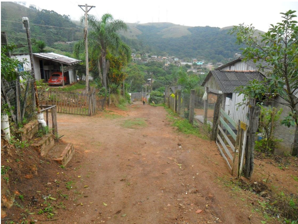
Fotografia 8 – Via de acesso precária e a alta declividade – Morro Pelado - sub-bacia do arroio Moinho - Porto Alegre/RS. Fonte: Rafael Lopez (27.05.2011).
