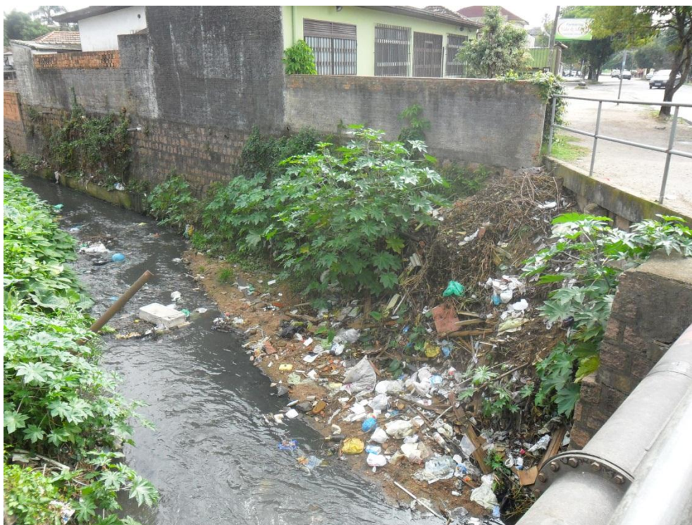
Fotografia 28 – Deposição de resíduos as margens do arroio e estrangulamento pelas residências - sub-bacia do arroio Moinho - Porto Alegre/RS. Fonte: Rafael Lopez (27.05.2011).
