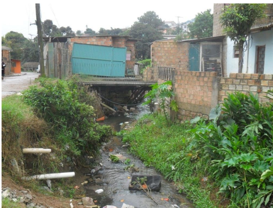
Fotografia 26 – Residências ocupando as margens do arroio - sub-bacia do arroio Moinho - Porto Alegre/RS. Fonte: Rafael Lopez (27.05.2011).
