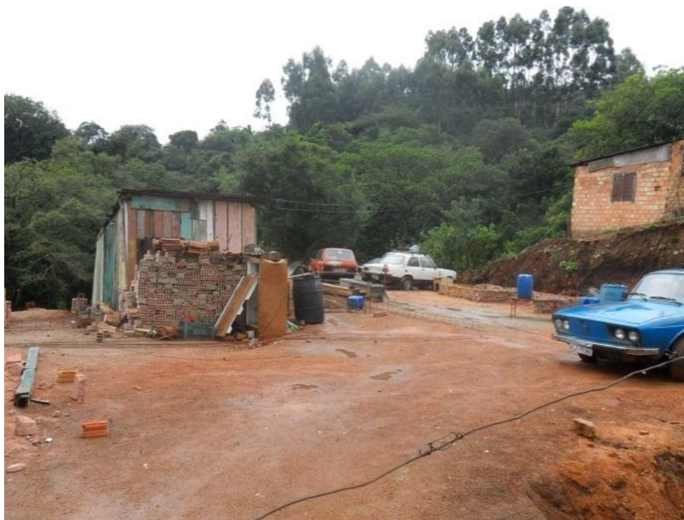
Fotografia 20 – Encosta superior da UP 4 – Prática de corte e aterro das encostas – Morro Pelado - sub-bacia do arroio Moinho - Porto Alegre/RS. Fonte: Rafael Lopez (27.05.2011).
