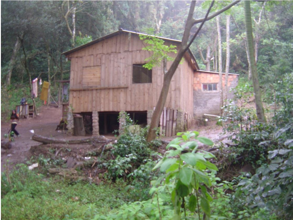
Fotografia 7 – Ocupação em fundo de vale – Morro Pelado - sub-bacia do arroio Moinho - Porto Alegre/RS. Fonte: Rafael Lopez (27.05.2011).
