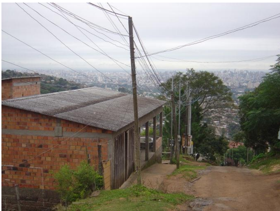
Fotografia 19 – Encosta superior da UP 5 – Instalações de energia elétrica – Morro Pelado - sub-bacia do arroio Moinho - Porto Alegre/RS. Fonte: Rafael Lopez (27.05.2011).
