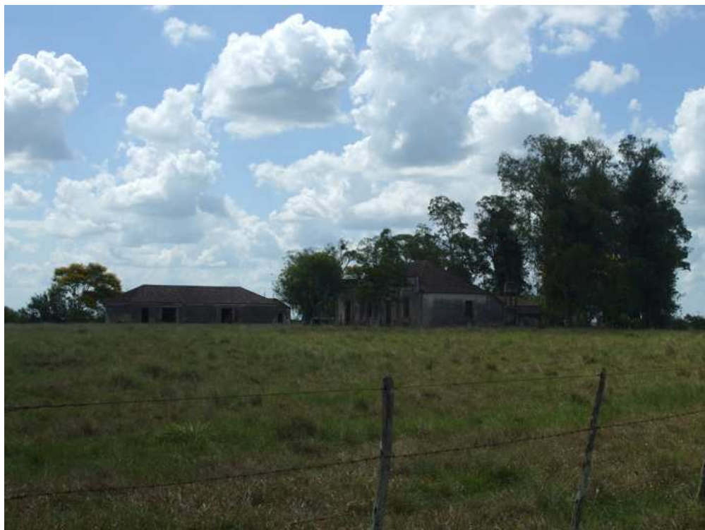
Figura 17 – Tapera em antiga sede de estância Fonte: fotos do autor
