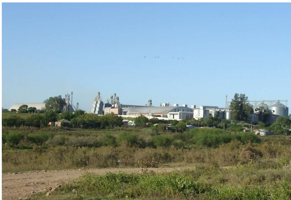
Figura 8 – CAI da COTRIJUÍ em Dom Pedrito – vista lateral
