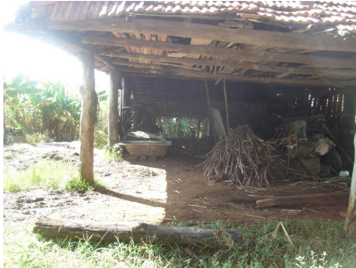
Figura 3 -Engenho antes do processo de qualificação das estruturas no município de Santo Antônio da Patrulha- RS ;
