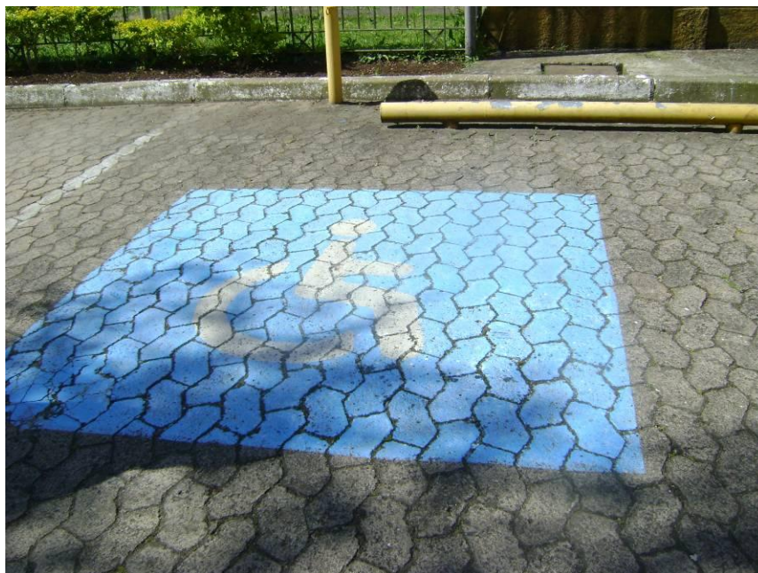
Fotografia 9 – Sinalização horizontal de vaga para pessoas com deficiência.
