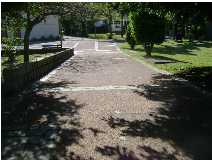
Fotografia 6 – Vista da parte superior da rampa.
