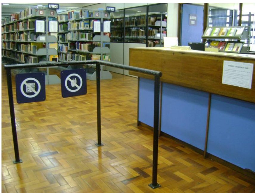
Fotografia 11 – Barra existente na entrada da biblioteca.
