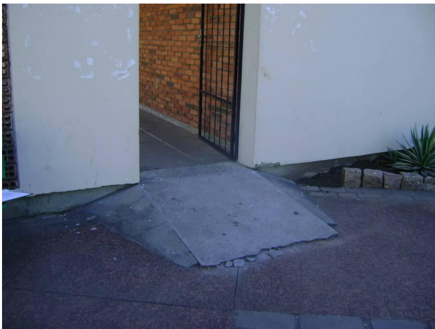
Fotografia 7 – Rampa de acesso ao prédio da biblioteca
