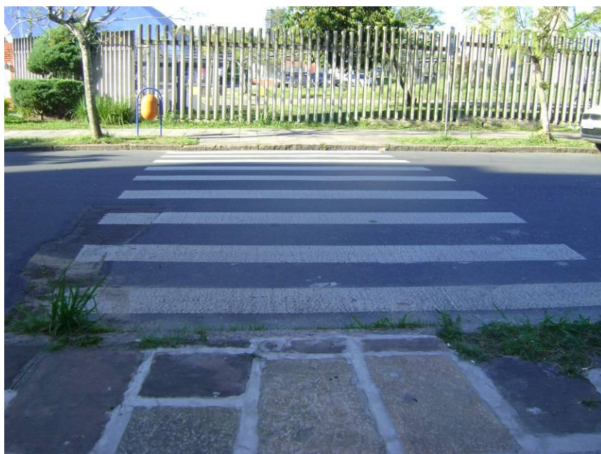
Fotografia 3 – Travessia com faixa sem rebaixamento de calçada.
