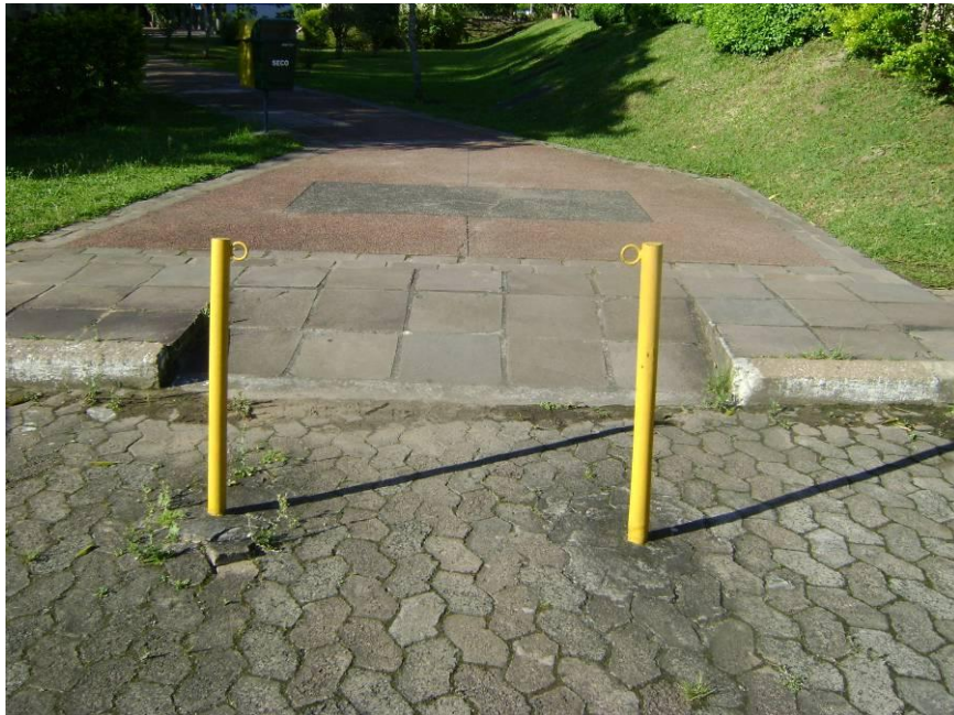
Fotografia 5 – Rebaixamento de calçada com interferência.
