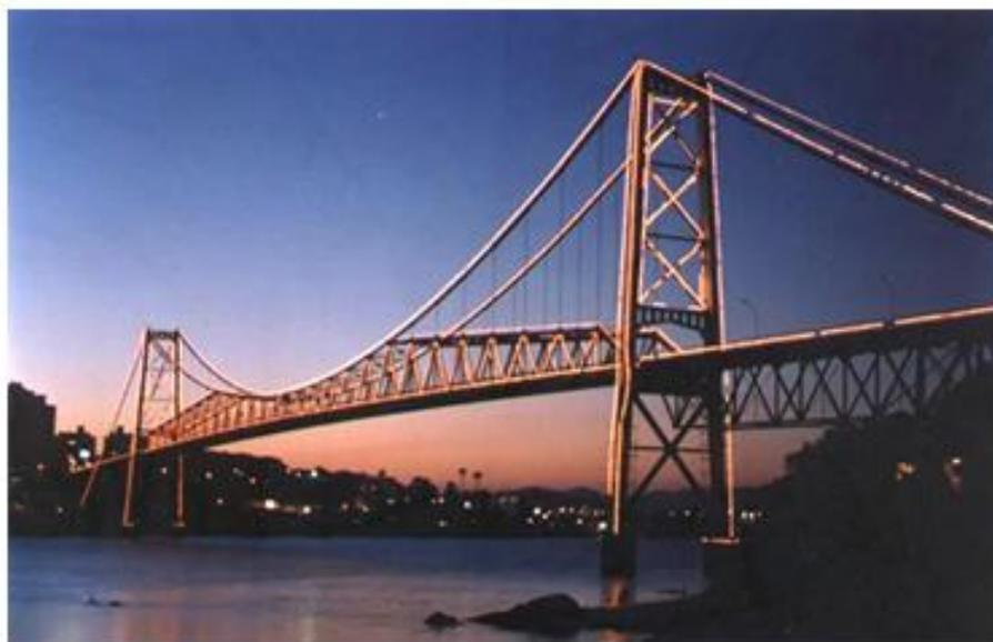
Figura 9 - Exemplos de aplicação da rigidez do triângulo em estruturas de construções civis
