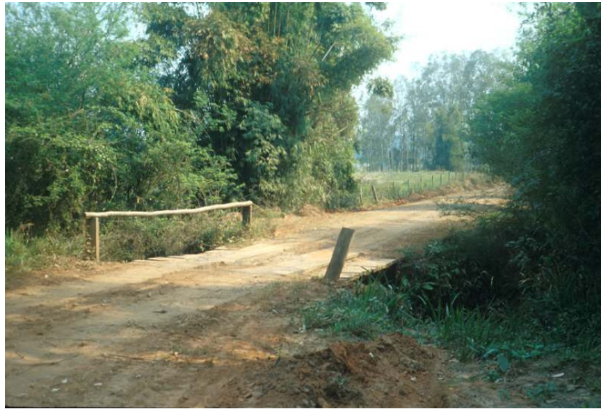
Figura 2. Ponte sobre o Arroio Portão.
