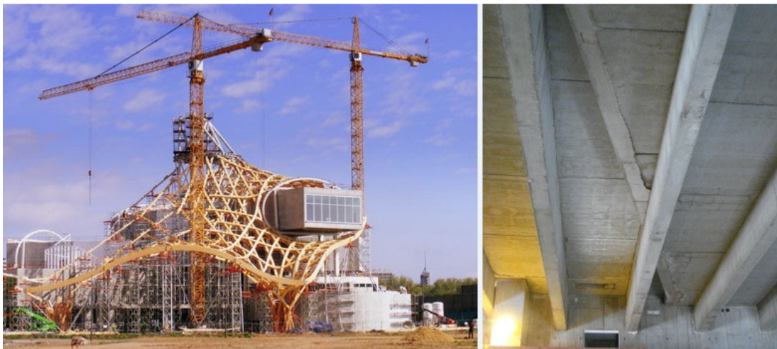
Figura 23: exemplo de viga protendida realizada na construção do Centre Pompidou (fornecido por CPA Engenharia Ltda)
