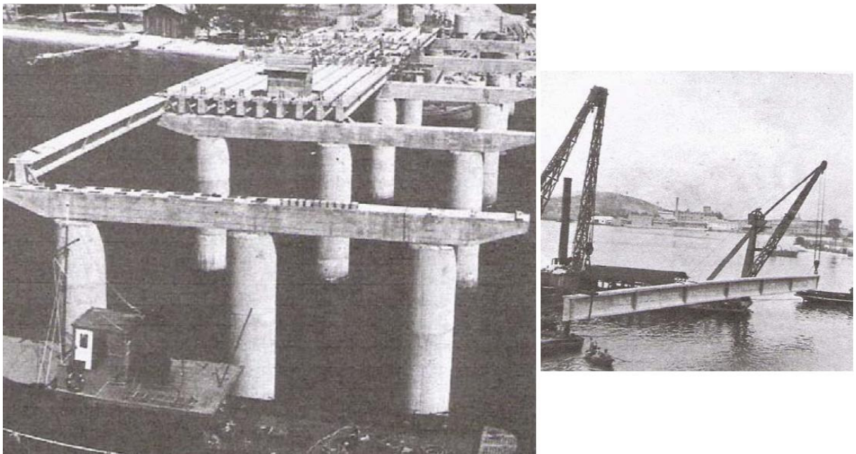
Figura 2: construção da Ponte do Galeão, no Rio de Janeiro (VASCONCELOS, 1992)
