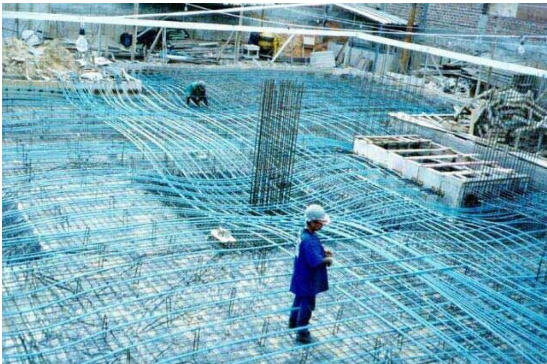
Figura 5: montagem das cordoalhas engraxadas e plastificadas em radier de edifício residencial de grande altura em Fortaleza (CAUDURO, 2000)
