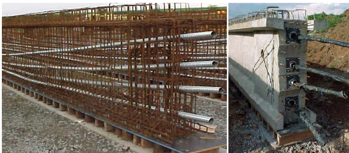
Figura 3: exemplo de peça submetida à protensão com aderência posterior
