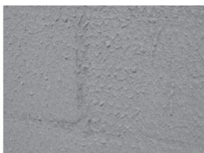
Figura 4: Aspecto do chapisco rolado (Fonte: Ceotto; Banduk; Nakakura, 2005)
