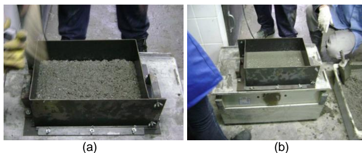
Figura 16: Fôrmas utilizadas para moldagem dos prismas de concreto: (a) aspecto do concreto antes de vibrado e (b) aspecto do concreto após vibração
