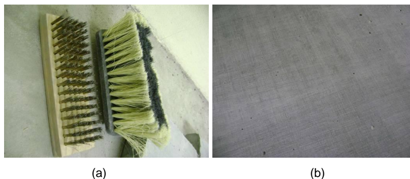
Figura 17: (a) escova de cerdas de aço e brocha, da esquerda para direita, utilizados para limpeza, e (b) aspecto final da superfície após escovação
