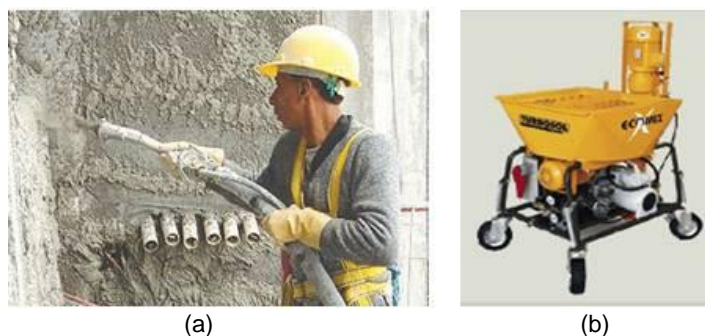
Figura 12: Projeção de argamassa através de bombas: (a) aplicação da argamassa e (b) misturador de argamassa
