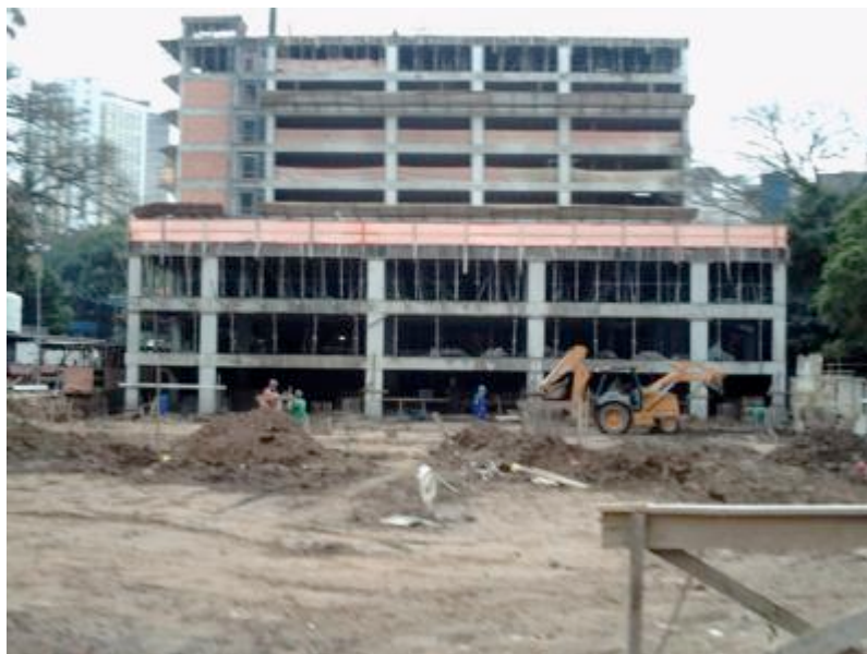
Figura 42 – Avanço da obra após conclusão do estudo
