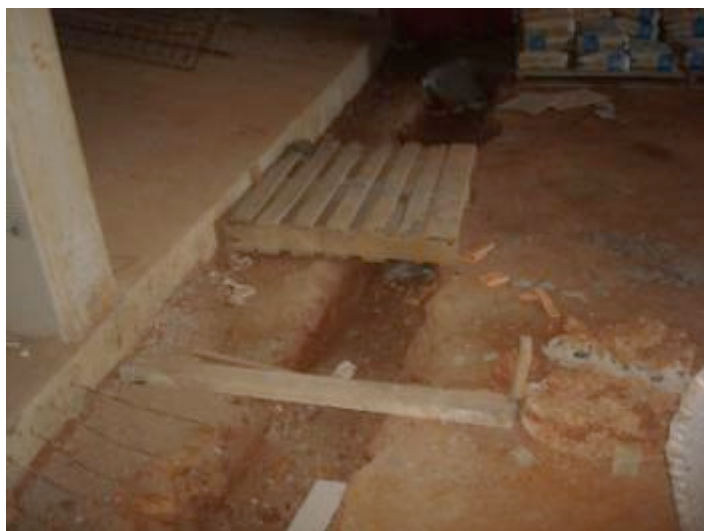
Figura 44 – Acesso à rampa no térreo
