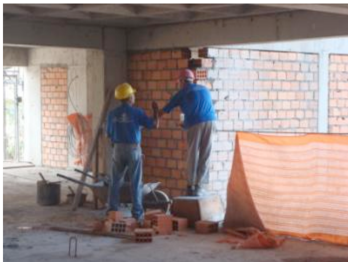
Figura 46 – Pedreiro sobre caixa de argamassa
