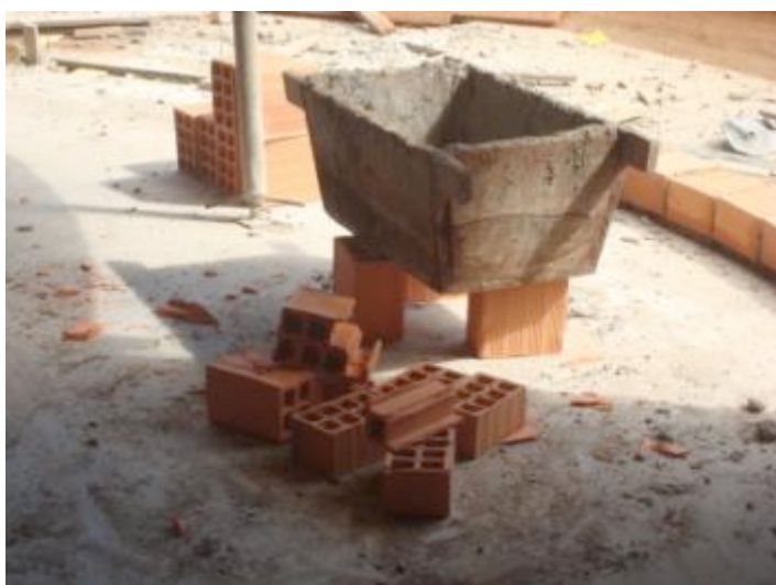
Figura 45 – Caixa de argamassa sobre blocos cerâmicos
