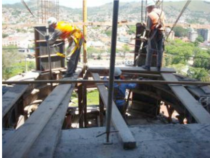
Figura 22 - Escada central 14° pavimento
