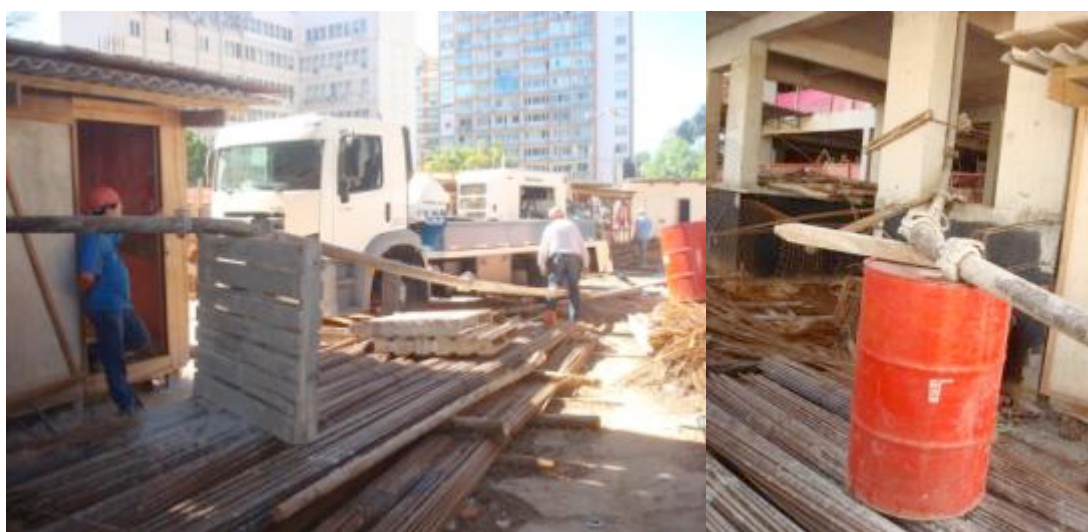
Figura 43 – Apoio da mangueira usada nas concretagens
