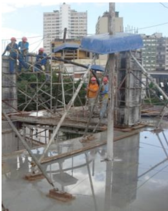
Figura 59 – Concretagem com improvisação devido a falta de equipamento adequado
