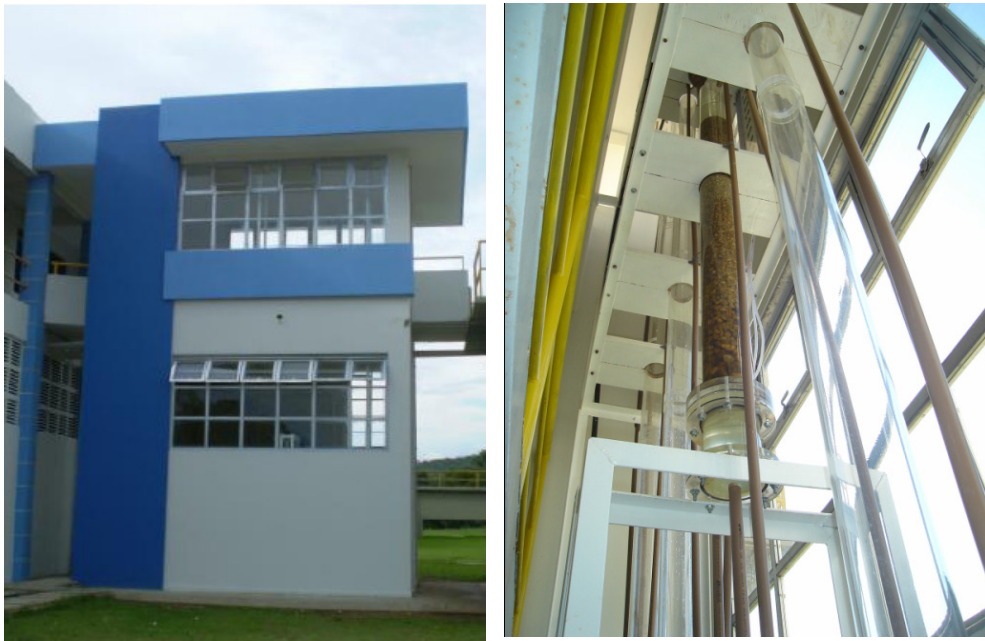
Figura 4.3: Vista externa e interna da IPDF (filtro de pedregulho no detalhe).
