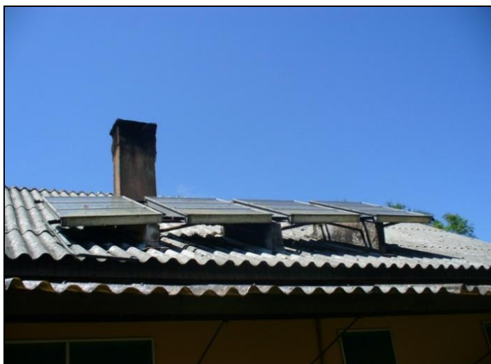
Foto 31 – Painel para captação de energia solar Fotografado pela autora
