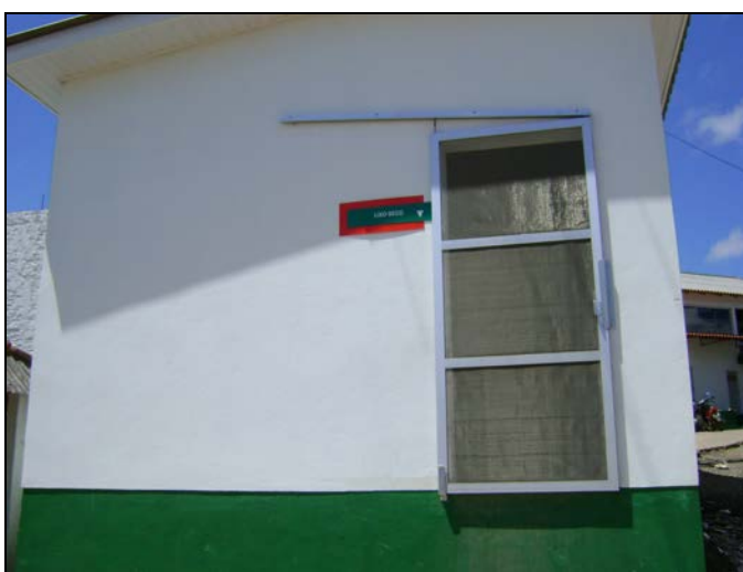
Figura 37. Local de acondicionamento temporário dos resíduos secos provenientes de outras atividades fora do processo industrial da Fábrica de Embutidos Borússia LTDA.
