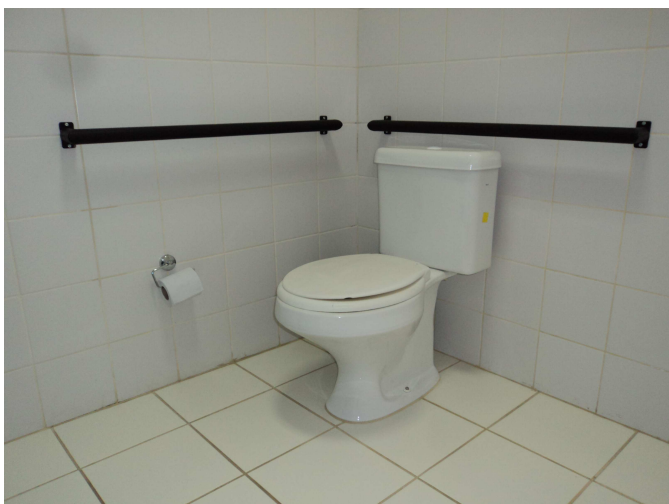
Figura 10 – Banheiro adaptado, com barras de apoio e estrutura ampla, retirado do arquivo pessoal da pesquisadora.
