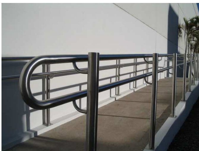
Figura 11 5 - Rampa de acesso, com proteção lateral.
