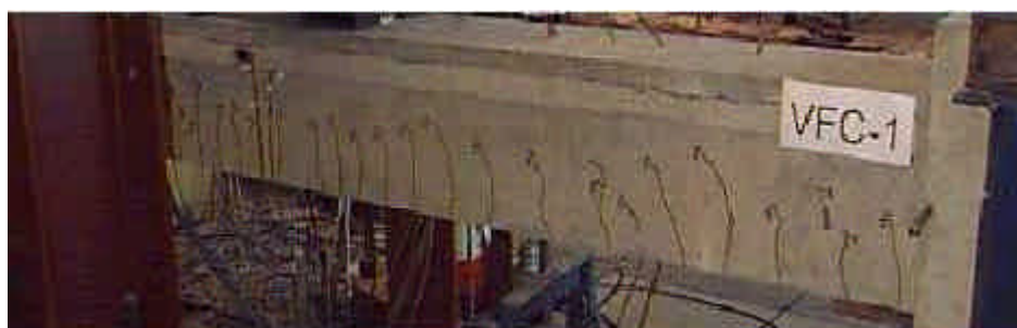
(b) Fissuração na VFC-1 (após a Protensão 2 – F_v = 35,1 kN)
