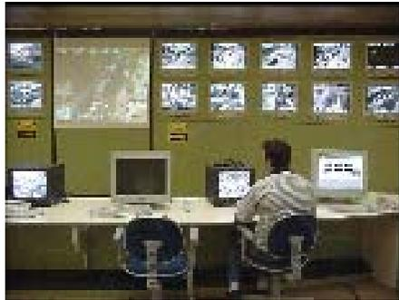
**Figura 21:** Detalhe do subsistema de CFTV do CTAFOR – Fortaleza.
