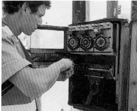
**Figura 5:** Controlador eletromecânico de tráfego. Fonte (Cucci, 1999).
