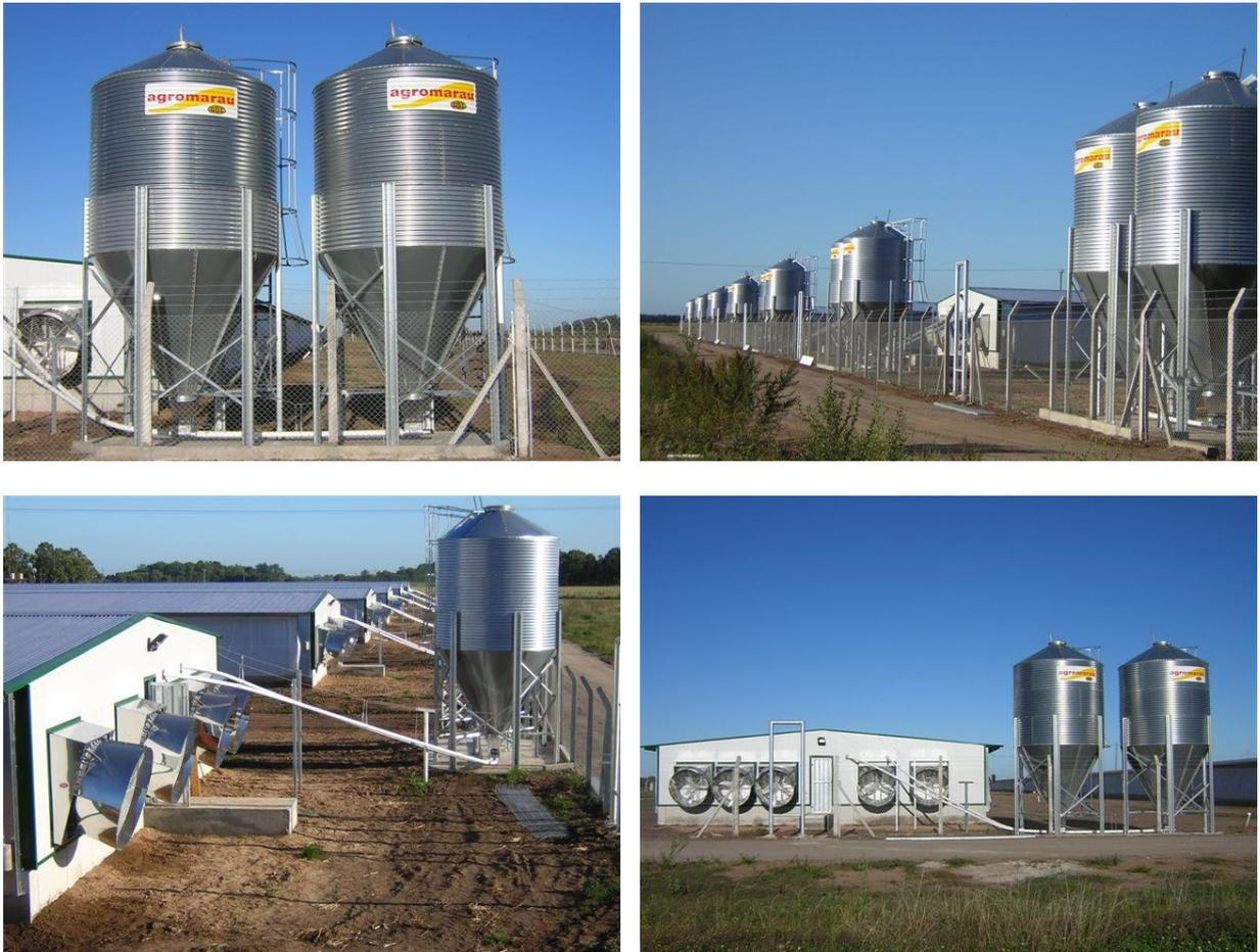
Figura 1.2-Silos armazenadores de ração (autorização para uso neste trabalho da GSI BRASIL)
