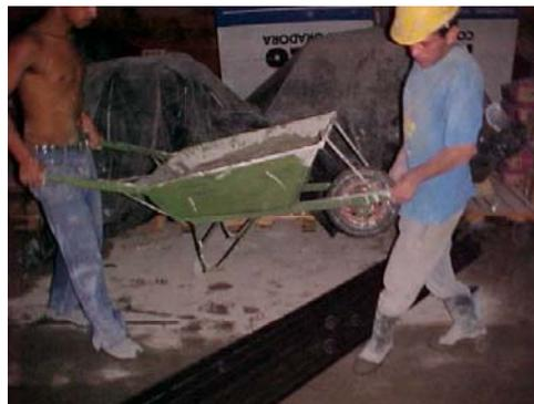
Figura 9 - Estoque de trilhos interrompendo o fluxo de trabalho da obra
