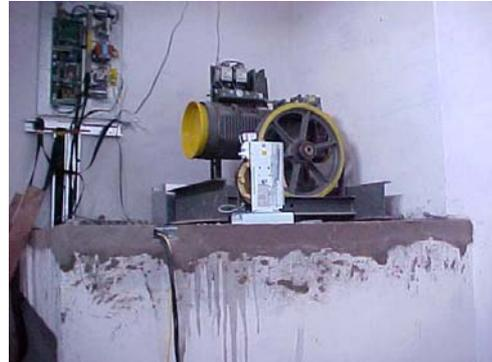
Figura 3 - Retrabalho na laje da casa de máquinas
