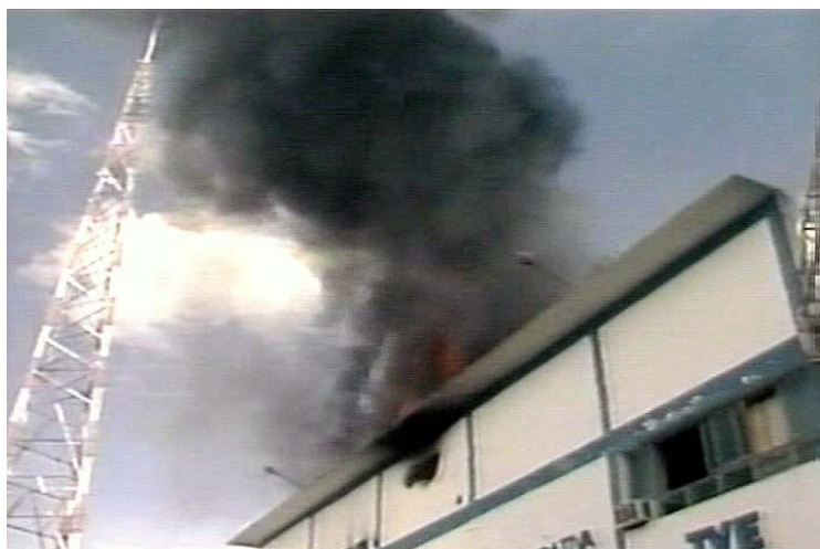
Figura 5 - Incêndio no Arquivo da TVE em 1983
