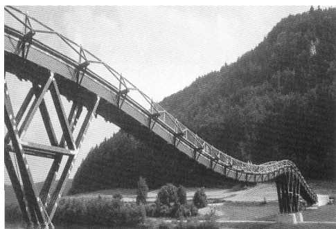
Figura 1 - Engenharia: passarela de pináceas na Alemanha
